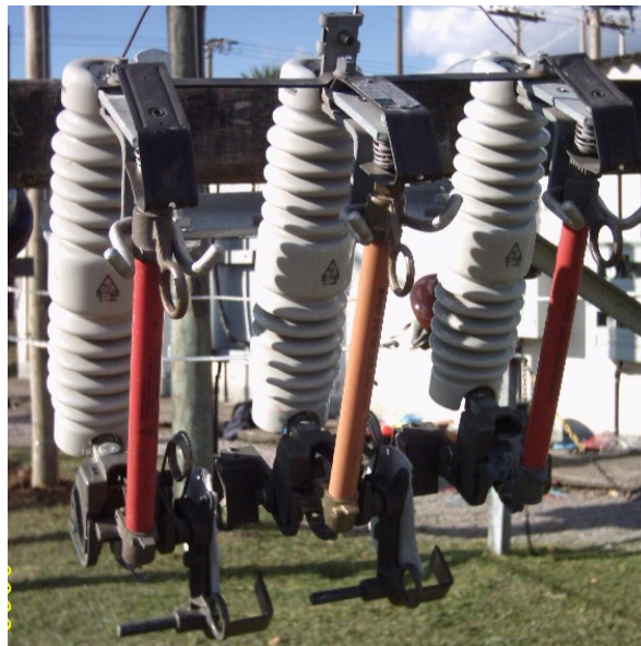
FIGURA 6.3: Chave Fusível Repetidora
