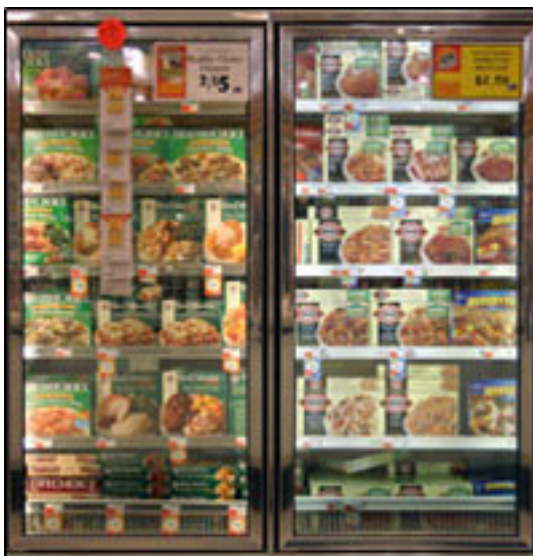
Figura 1.8 - Iluminação com lâmpada fluorescente, à esquerda e iluminação empregando LEDs, à direita (ASSIST, 2008).
