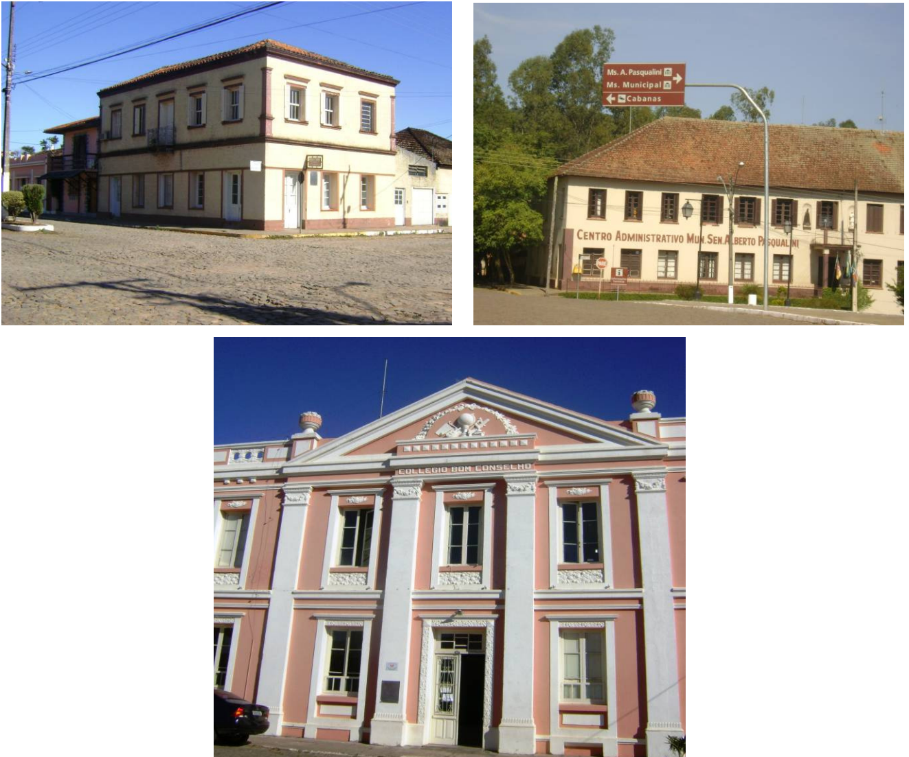
Figura 8: Arquitetura antiga preservada na Quarta Colônia . Respectivamente, prédio residencial em Silveira Martins, Centro Administrativo de Ivorá e Colégio Bom Conselho em Silveira Martins. Fotos da autora.
