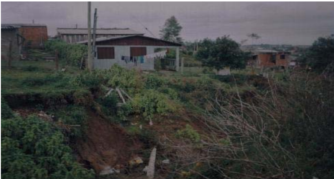
Figura 3 – Processo erosivo na rede de drenagem na área de estudo. (braço da voçoroca em processo de expansão próximo das residências). Fonte: Trabalho de campo em setembro de 2003.
