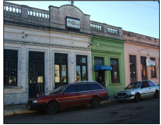
Fotografia 21: Fachada das residências geminadas em Cruz Alta/RS.
