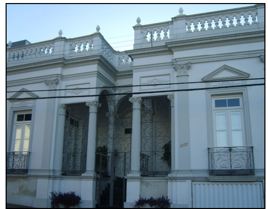
Fotografia 23: Antiga construção de Inspiração lusa em Cruz Alta/RS.
