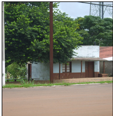
Fotografia 7: Antiga residência de inspiração lusa em F. dos Valos/RS. Fonte: Trabalho de Campo, 2011.
