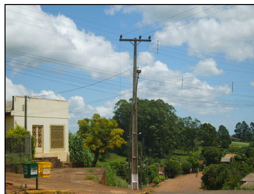
Fotografia 12: Construção de inspiração lusa em Saldanha Marinho/RS.
