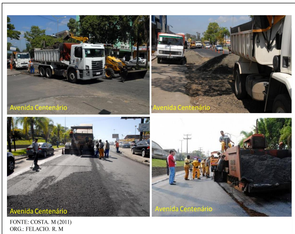
Figura 12- Obras de revitalização em trechos da Avenida Centenário em Criciúma-SC
