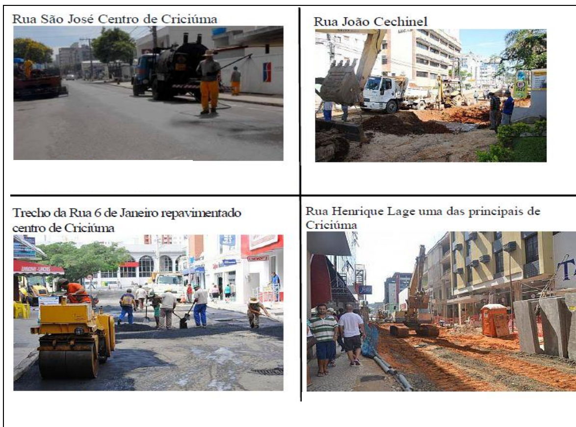
Figura 13- Obras no bairro São José localizado no centro da cidade de Criciúma-SC
