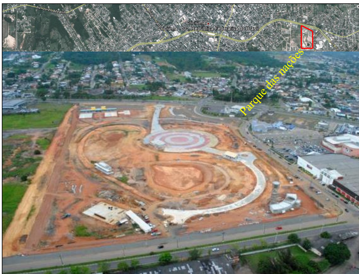
Figura 14- Parque das Nações em fase de construção localizado no bairro Próspera Criciúma-SC
