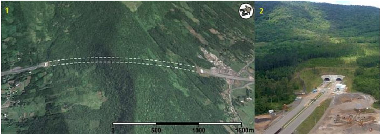
Figura 12 - Túnel rodoviário sob o Morro Alto na BR 101/RS, em Osório. Legenda: 1) Demonstração da dimensão desta estrutura e demonstração de como a conectividade florestal mantém seu sucesso, via imagem de satélite do Google Earth. 2) Emboque Norte do mesmo túnel.
