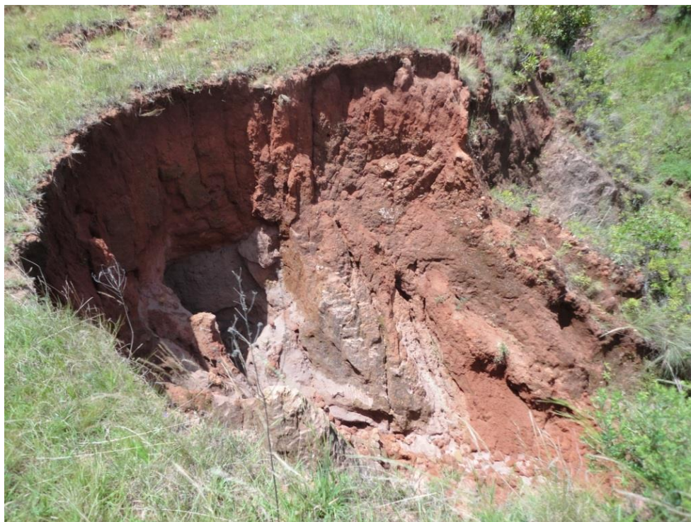
Figura 45 - Voçoroca em São Valentim, distrito de Santa Maria. Ocupação por pasto.
