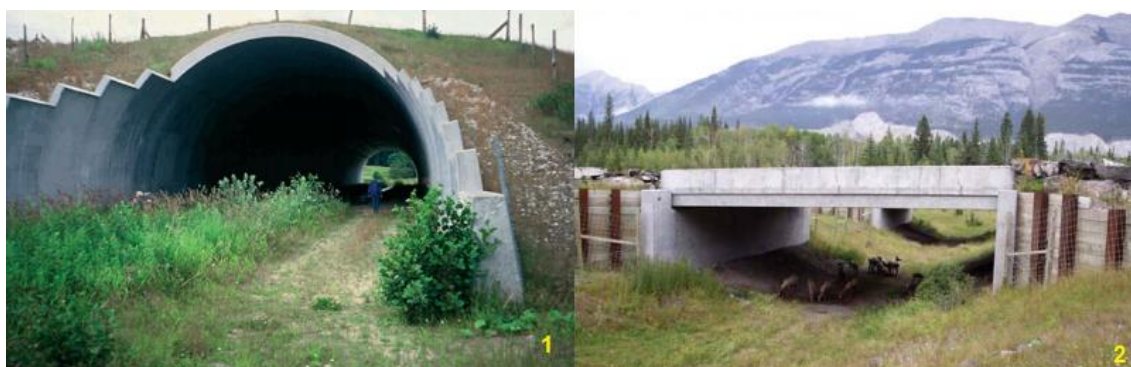
Figura 6 - Passagens inferiores multiuso. Legenda: 1) Na Dinamarca, possui diâmetro de 13 m com 8 metros iluminados, possuindo 87,5 m de comprimento de teto e 115m de comprimento de solo. É regularmente usada por raposas, tourões, furões e martas. 2) Passagem inferior multiuso sendo utilizada por mamíferos de médio porte.
