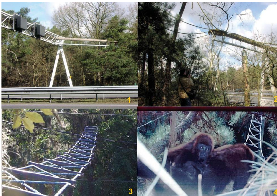
Figura 13 - Passagens pelo estrato arbóreo no Brasil e no exterior. Legenda: 1) Esta passagem aproveita a estrutura para a sinalização da rodovia; 2) Cordas estendidas de uma passagem superior de madeira para a floresta, notando-se que é uma distância curta para a chega às árvores; 3) Ponte de corda instalada em Porto Alegre, Rio Grande do Sul pelo projeto Macacos Urbanos; 4) Bugios-ruivos ( Alouatta guariba ) utilizando as passagens aéreas como o modo mais seguro de passagem pela rodovia.
