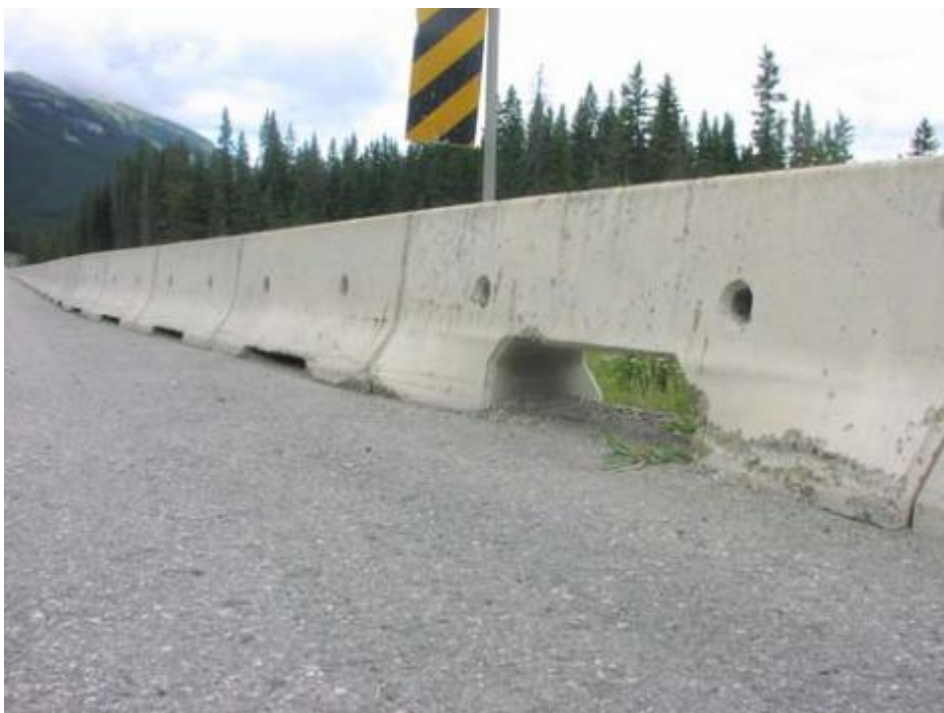
Figura 4 - Aberturas ovaladas em Barreiras Jersey para a passagem de fauna de pequeno porte.
