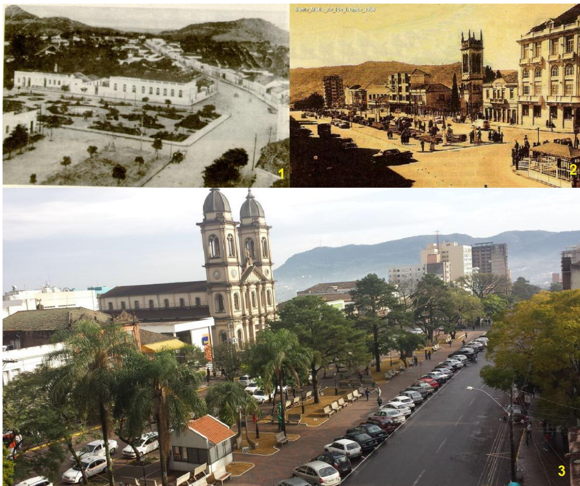
Figura 16 - Arborização escassa no bairro Centro de Santa Maria. 1) Praça Saldanha Marinho em 1905. Observa-se, ao fundo, o desmatamento da Mata Atlântica remanescente nos morros do
