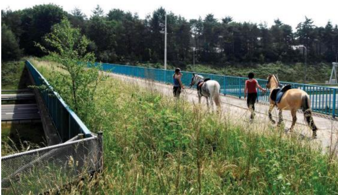
Figura 11 - Uso humano em uma pista e faixa vegetada ao lado para passagem da fauna. Recomenda-se uma faixa maior de vegetação e apenas uma trilha estreita para passagem humana e de animais domésticos.
