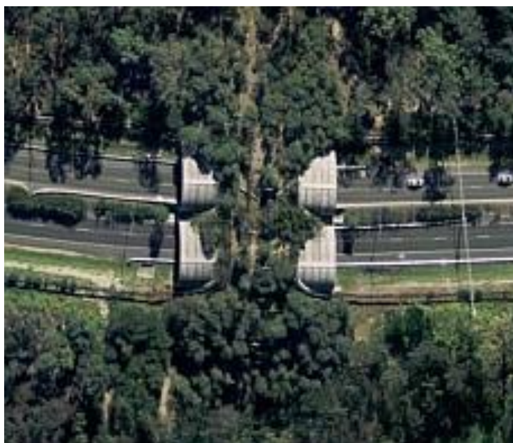
Figura 10 - Vista aérea através de imagem por satélite da passagem superior estreita australiana na Campton Road, Brisbane.
