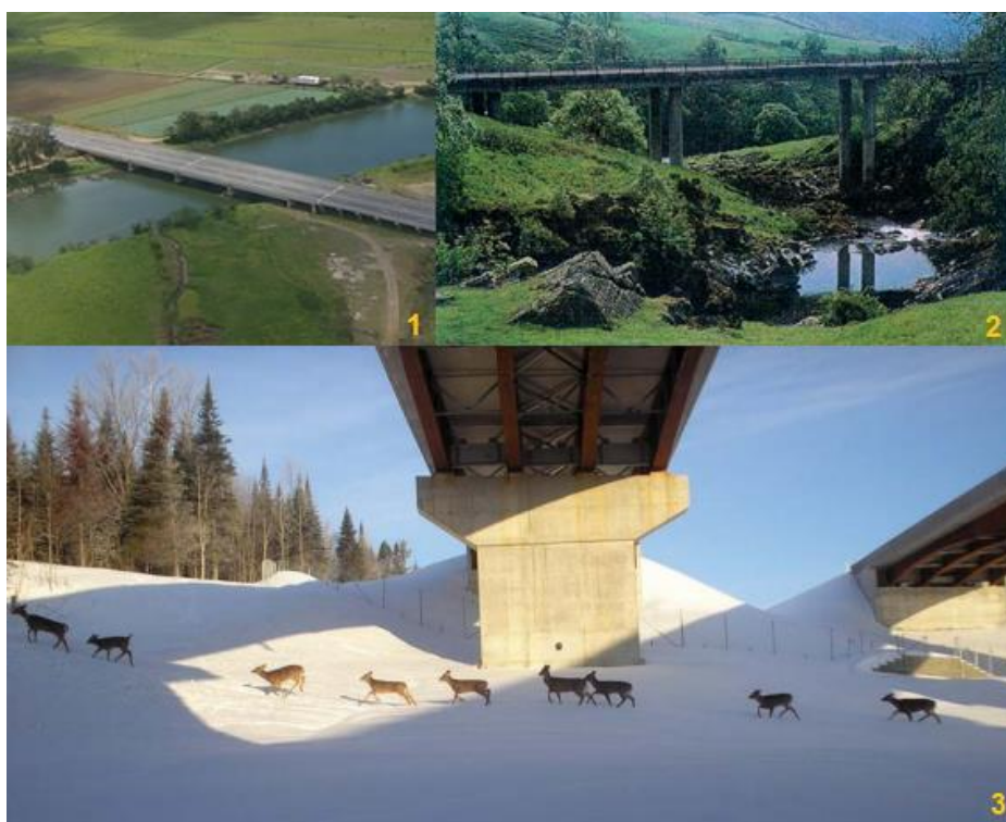
Figura 7 - Elevada e viadutos rodoviários como modo de manutenção da conexão da biodiversidade e hidrografia. Legenda: 1) Elevada sobre trecho de várzea e do próprio curso d'água do Rio Maquiné (RS) na BR 101; 2) Viaduto localizado ao norte da Inglaterra, deixando o vale do rio intacto; 3) Viaduto possibilitando a passagem inferior de fauna selvagem no Quebec.
