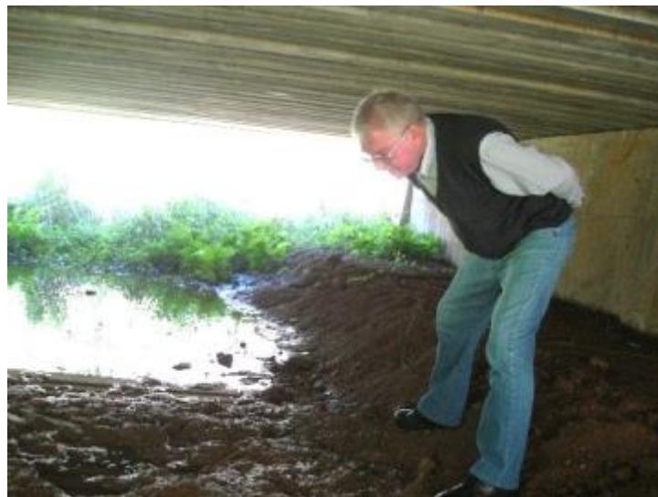
Figura 5 - Passagem inferior pequena na rodovia RS 486 (Rota do Sol).
