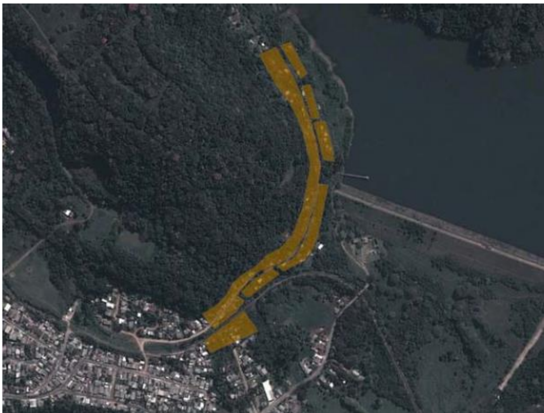
Figura 19 - Detalhe da zona de risco da Montanha Russa, ao sopé do Morro Cechella.
