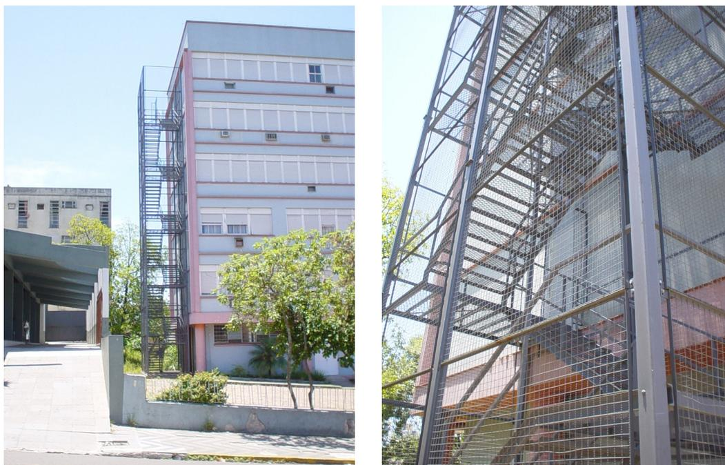
FIGURA 95a – Exemplo de escada externa metálica.
