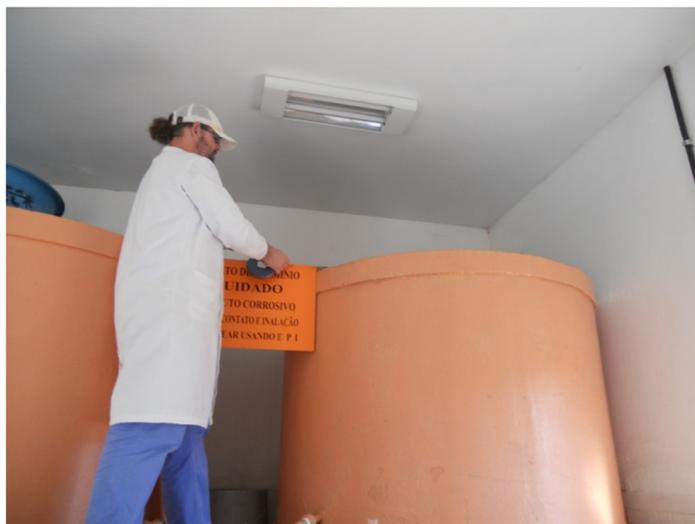
Figura 3.6 – Tina de dosagem de sulfato de alumínio da ETA de Candelária/RS.
