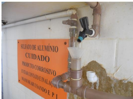
Figura 3.4 – Torneira de dosagem de sulfato de alumínio da ETA de Candelária/RS.
