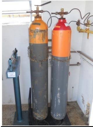
Figura 2.11 – Cilindros de cloro gás da ETA de Candelária/RS.
