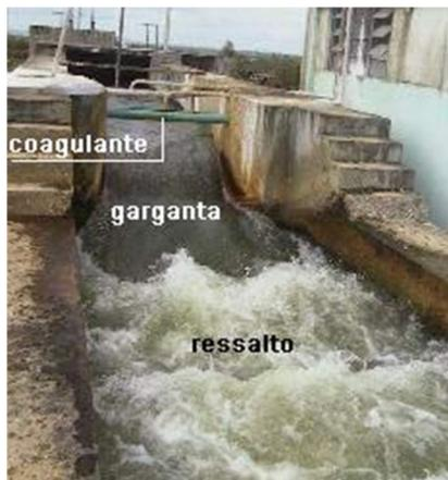
Figura 2.7 – Misturador rápido tipo calha Parshall.
