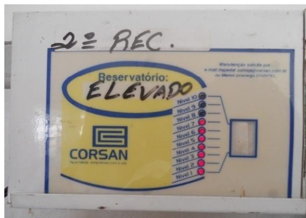
Figura 3.17 – Marcador de nível do reservatório elevado da ETA marcando nível 7.
