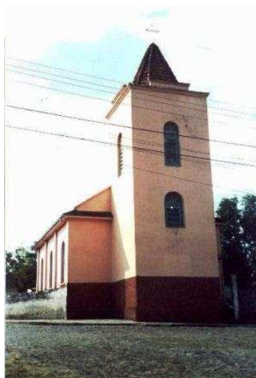
Imagem 05- Igreja Santa Catarina no Bairro Itararé/Santa Maria-RS, antes da reforma.
