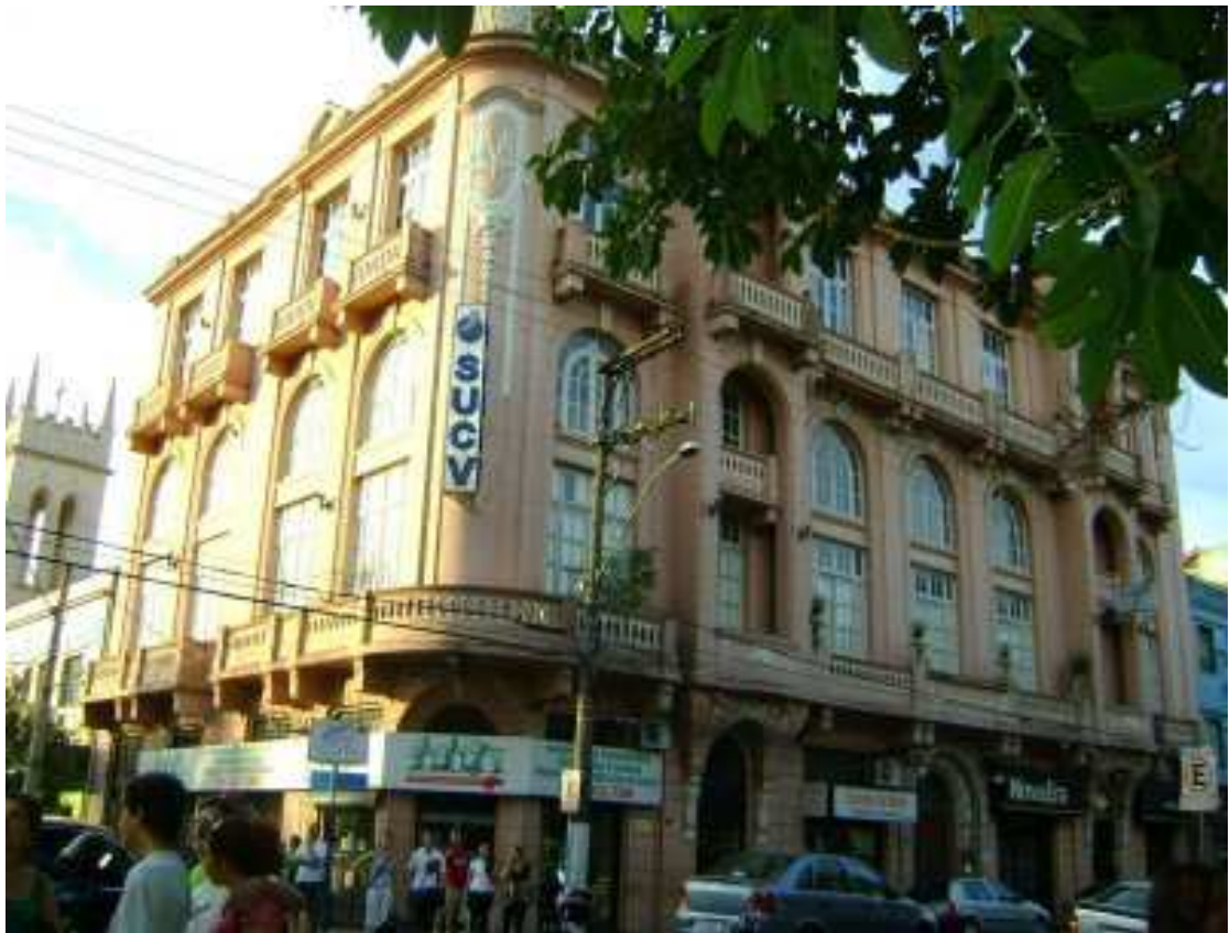
Imagem 03- Prédio da SUCV em Santa Maria
