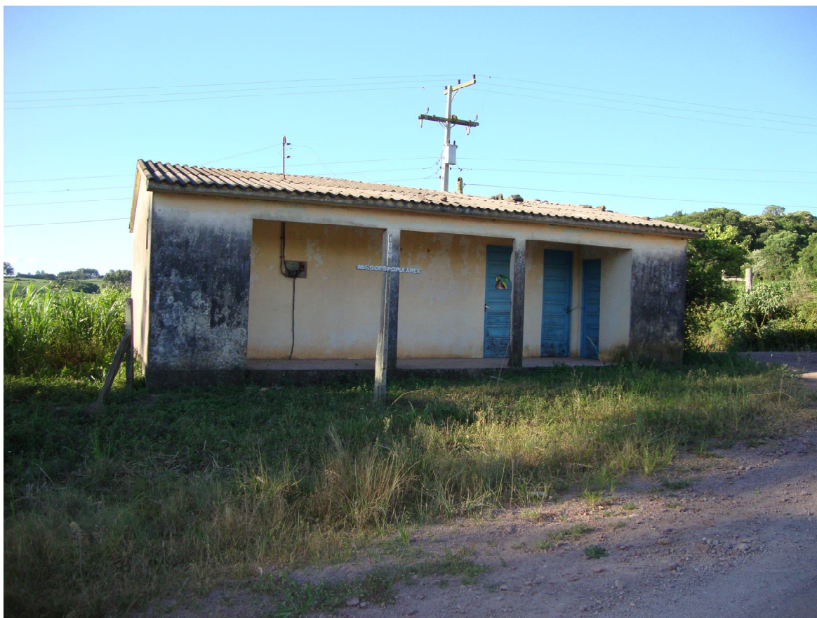
Figura 3 – Capela Santa Terezinha localizada na Linha Um.
