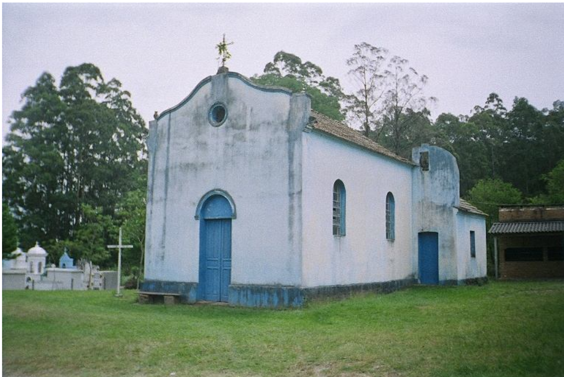
Figura 12 – Capela São Vitor e Santa Corona localizada em Val Feltrina.
