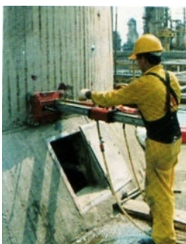
Figura 24. Extração do testemunho da estrutura (FIGUEIREDO, 2005, p. 994).
