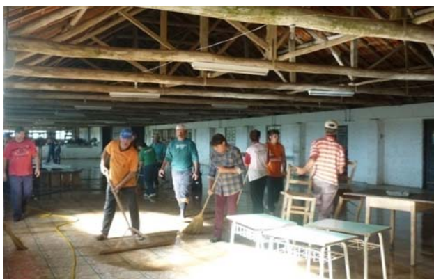
Figura 37 - Trabalho de limpeza no salão da comunidade da Linha Quarta Norte, Silveira Martins. Fonte: Coelho (2010)
