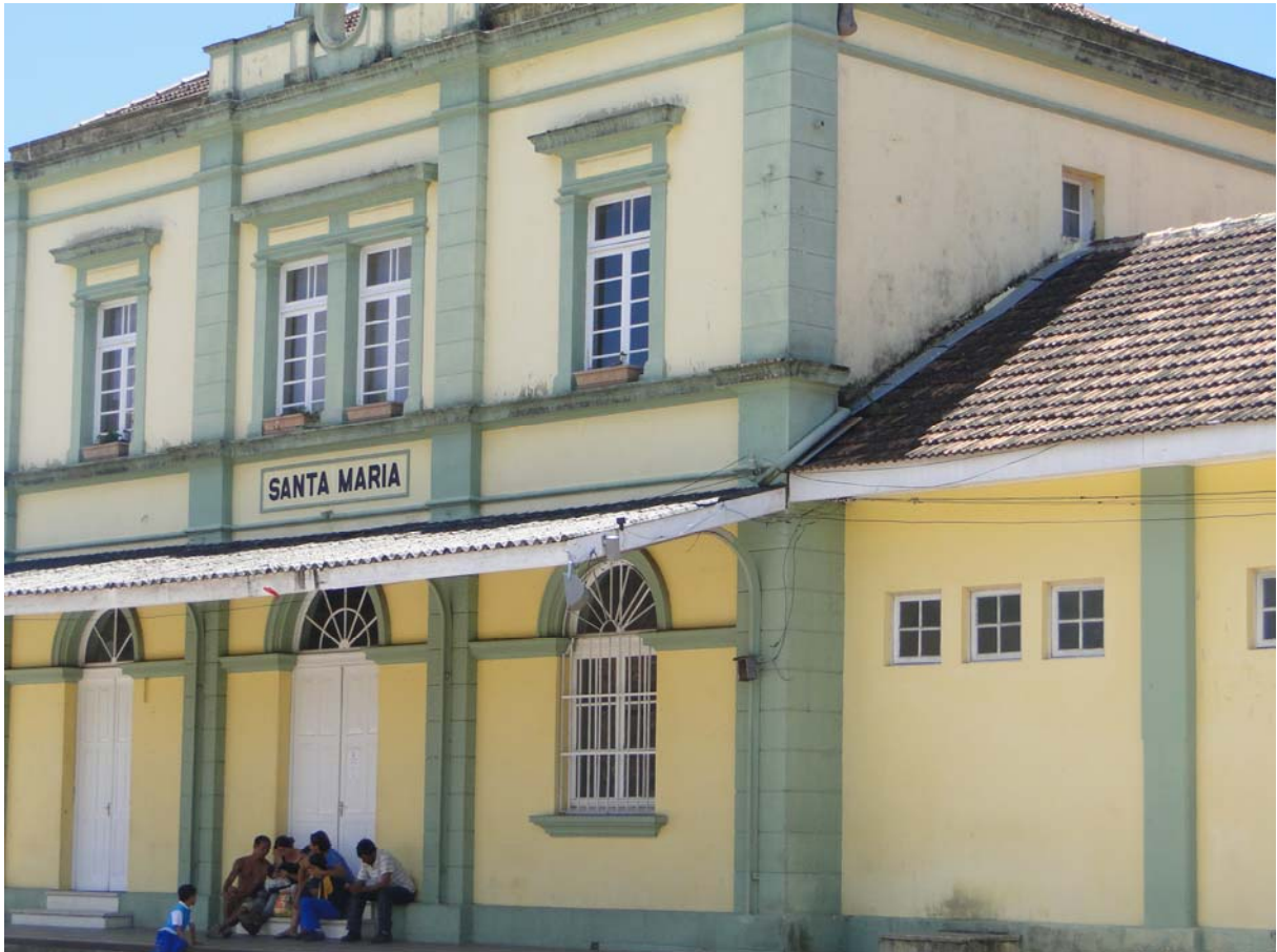
Figura 7 – Entrada principal da Estação Ferroviária, após a restauração. Fonte: Arquivo Pessoal (2011)
