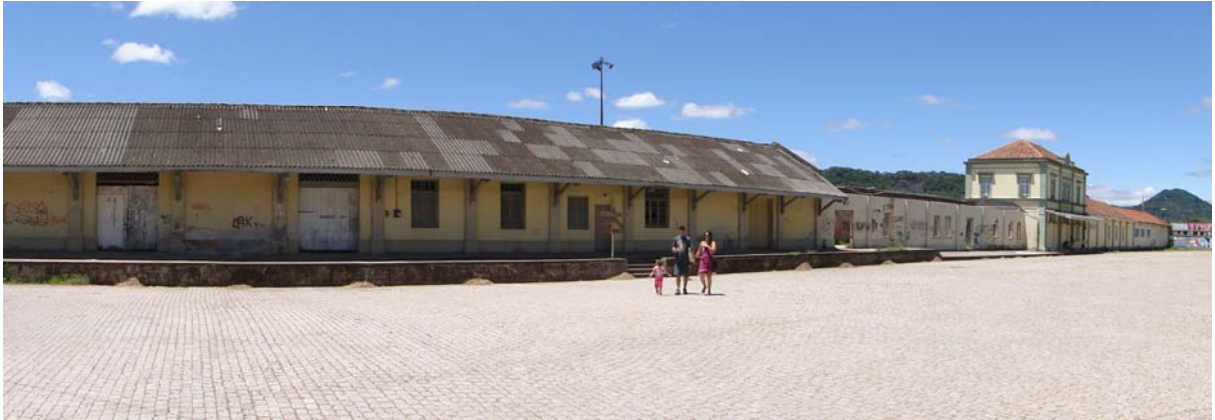
Figura 3 - Vista atual da Ferroviária, armazéns e calçamento, tombados, 2011. Fonte: Arquivo Pessoal
