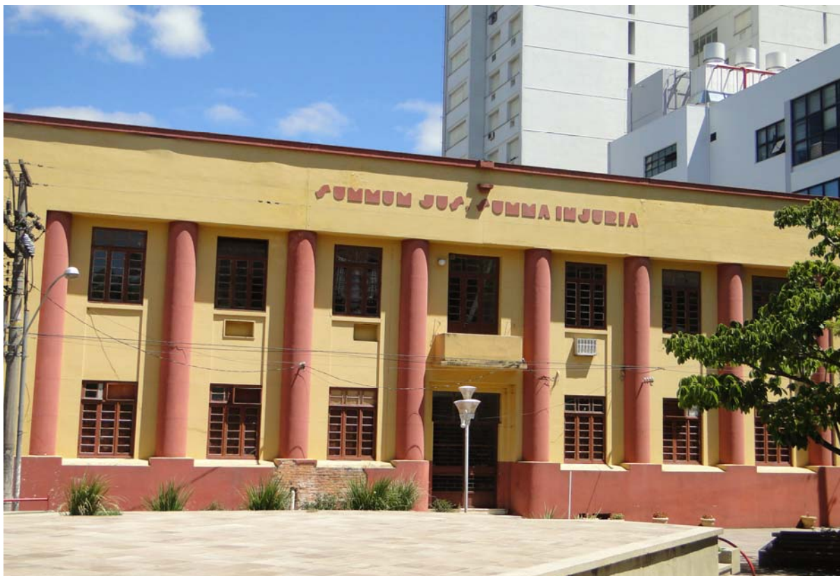
Figura 16 - Antigo Palácio da Justiça (Fórum); tombado pelo Município e atual Casa de Cultura. Parte dos recursos para a restauração deve vir de empréstimos internacionais (2011).
