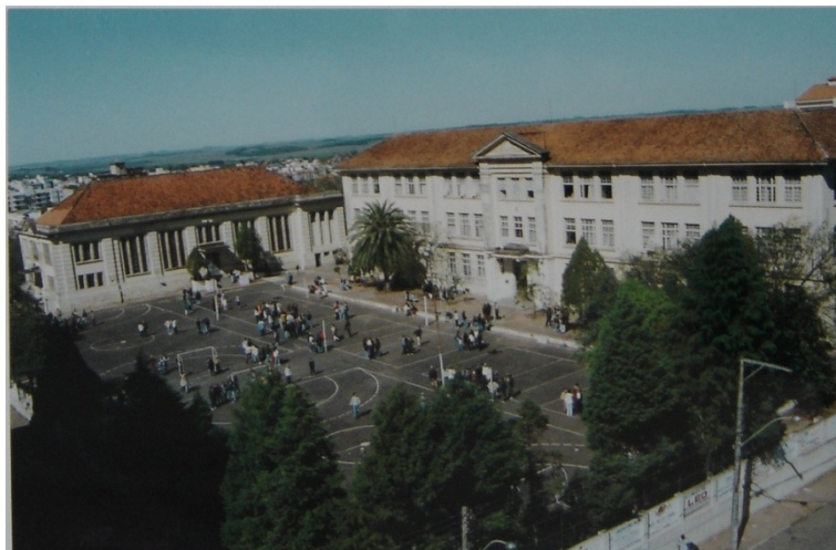
Figura 48 – Situação do conjunto entre 1997 a 1999. FONTE: arquivo IEEOB.
