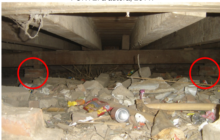
Figura 40 – Pilaretes de sustentação da estrutura do piso na metade direita do prédio. FONTE: a autora, 2011.
