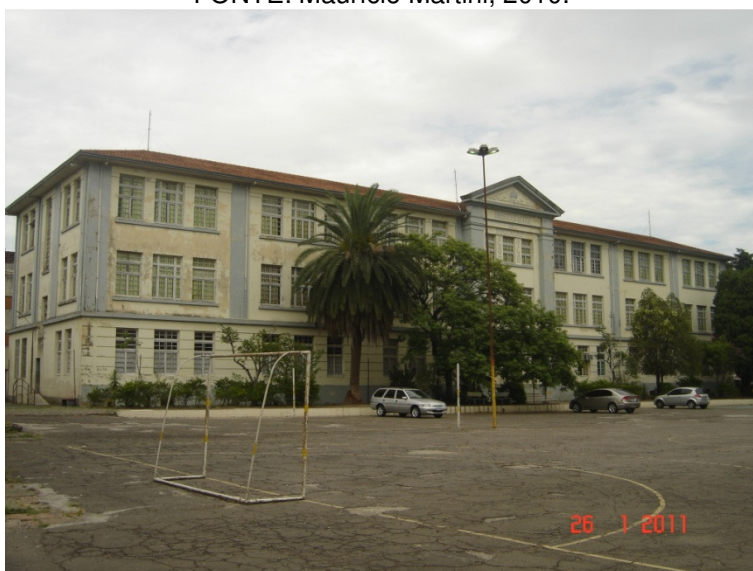
Figura 62 – Situação do prédio central em 2011. FONTE: a autora, 2011.
