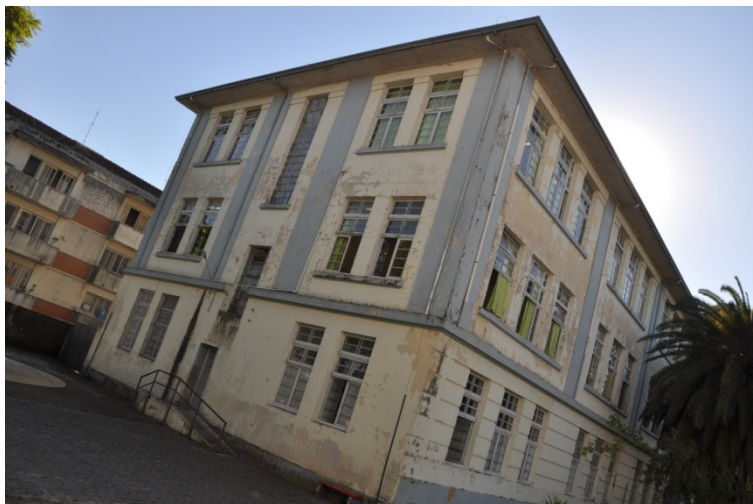
Figura 61 – Situação do prédio central em 2010. FONTE: Maurício Martini, 2010.
