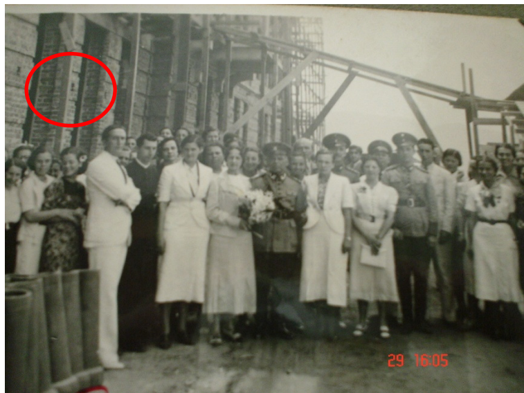
Figura 43 – Prédio central em construção (1940) – marcação da parede externa portante. FONTE: arquivo IEEOB.
