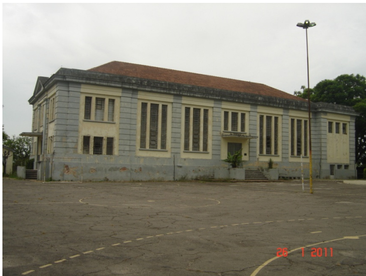
Figura 64 – Situação do auditório em 2011. FONTE: a autora, 2011.
