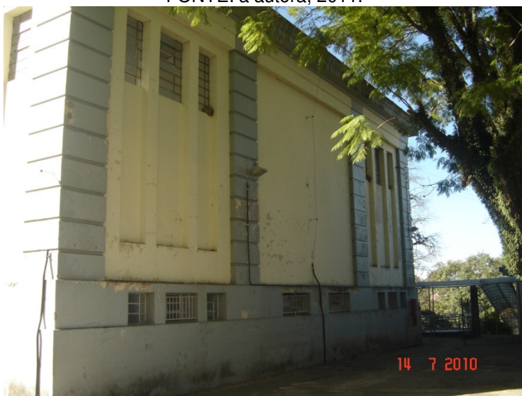
Figura 63 – Situação do auditório em 2010. FONTE: a autora, 2010.
