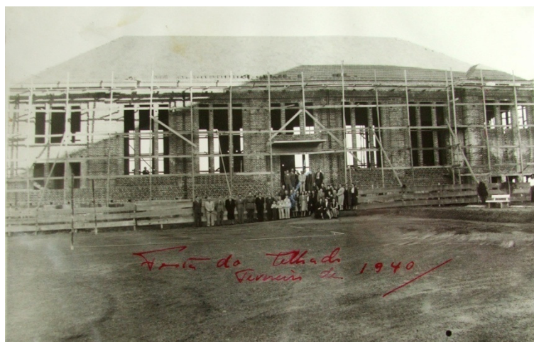
Figura 54 – Auditório em construção (1940). FONTE: arquivo IEEOB.
