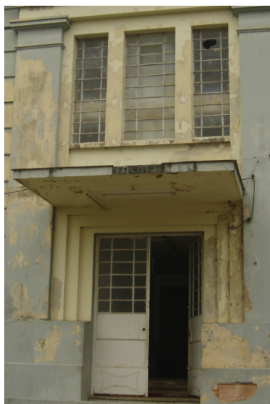
Figura 55 – Aberturas: uso de caixilhos de ferro e vedação em vidro. FONTE: a autora.
