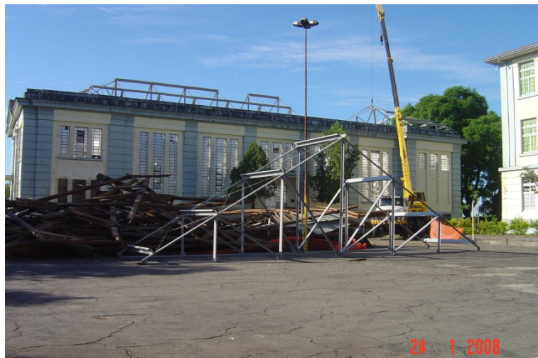
Figura 57 – Substituição da estrutura do telhado do auditório. FONTE: arquivo IEEOB.
