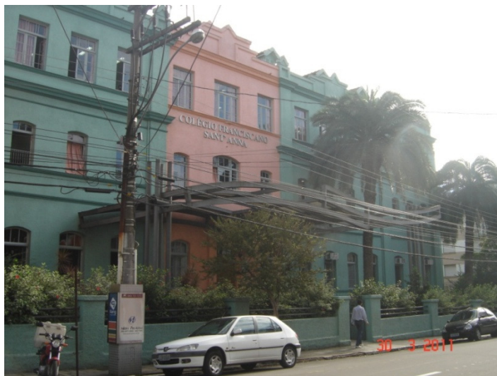
Figura 20 – Prédio do Colégio Sant'Anna/Santa Maria-RS. FONTE: a autora, 2011.
