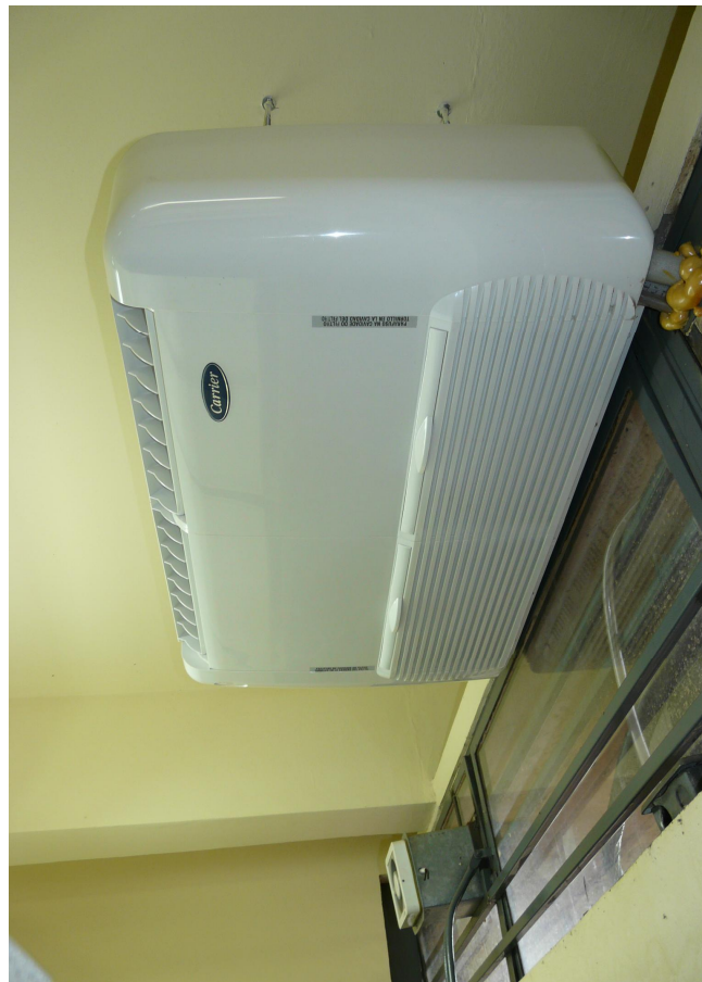
Figura 6 . Instalação de equipamentos de climatização. (Foto Carlos Blaya).
