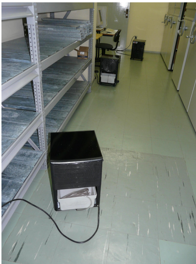
Figura 7 . Posicionamento dos equipamentos desumidificadores. (Foto Carlos Blaya).
