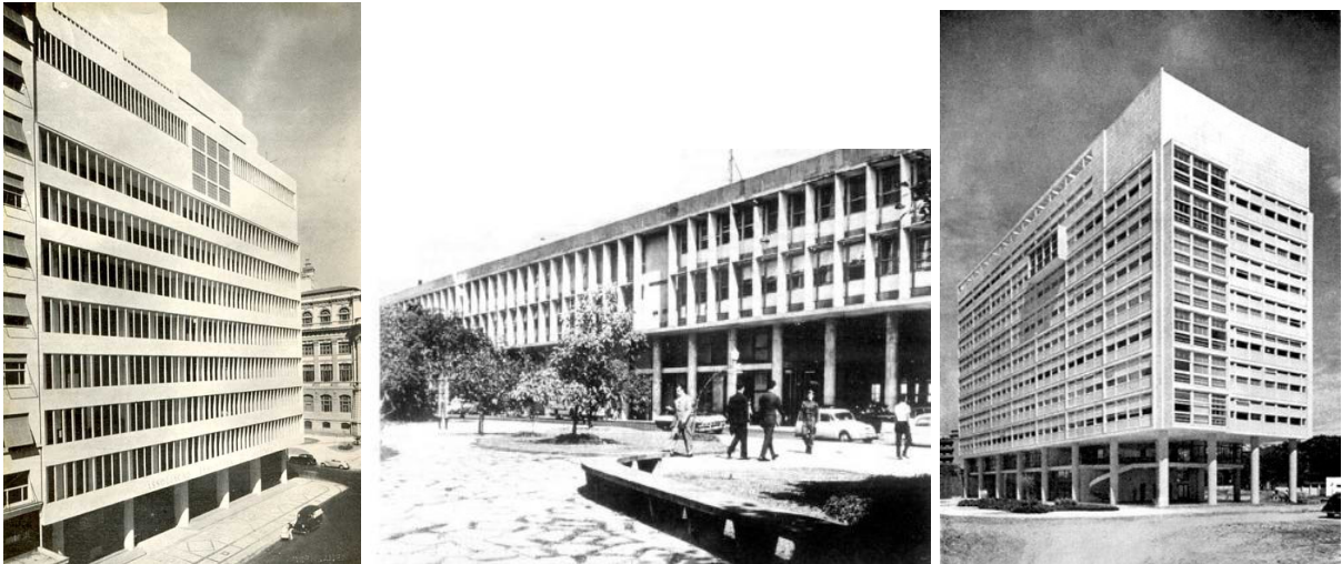
Figuras 3, 4 e 5 - À esquerda, Associação Brasileira de Imprensa (RJ); ao centro, Aeroporto Santos Dumont (RJ); à direita, Prédio de Resseguros do Brasil. Fontes: http://monolitho.wordpress.com ; http://www.arcoweb.com.br .
