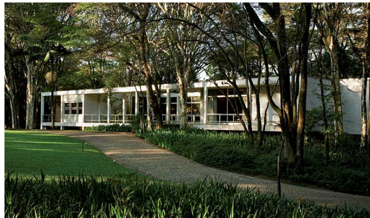
Figuras 57, 58 e 59 - Acima e à esquerda, Casa Bardi; à direita, Residência Milton Guper; ao centro, Residência Oscar Americano. Fontes: http://www.vitruvius.com.br
