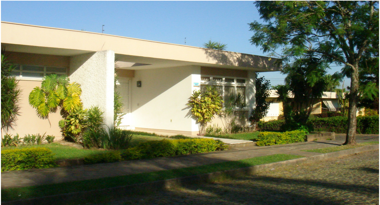
Figura 92 - Foto da residência desde a rua. Fonte: Ana Paula Nogueira, maio de 2009.
