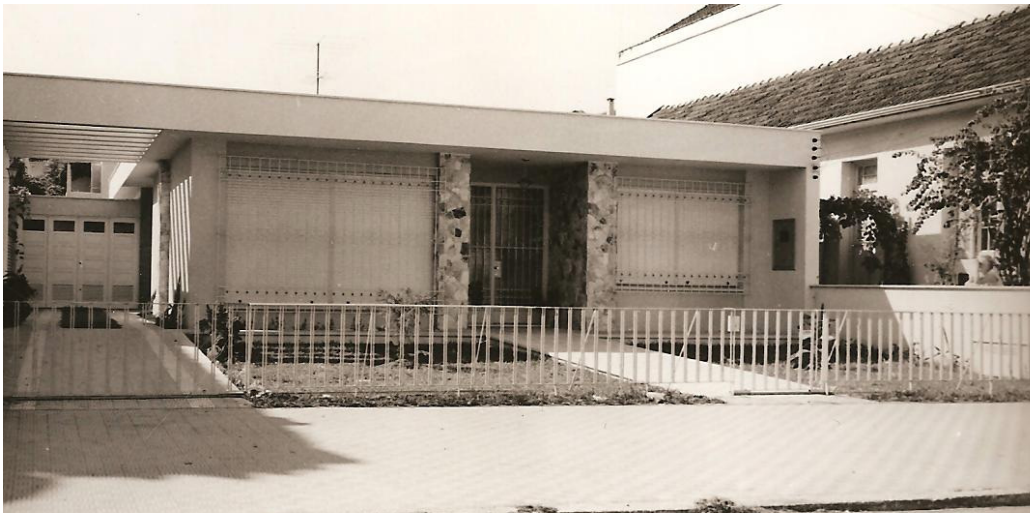
Figura 116. Residência Francisca Siqueira de Lucena, POA, 1967. Fonte: Arquivo do Arquiteto
