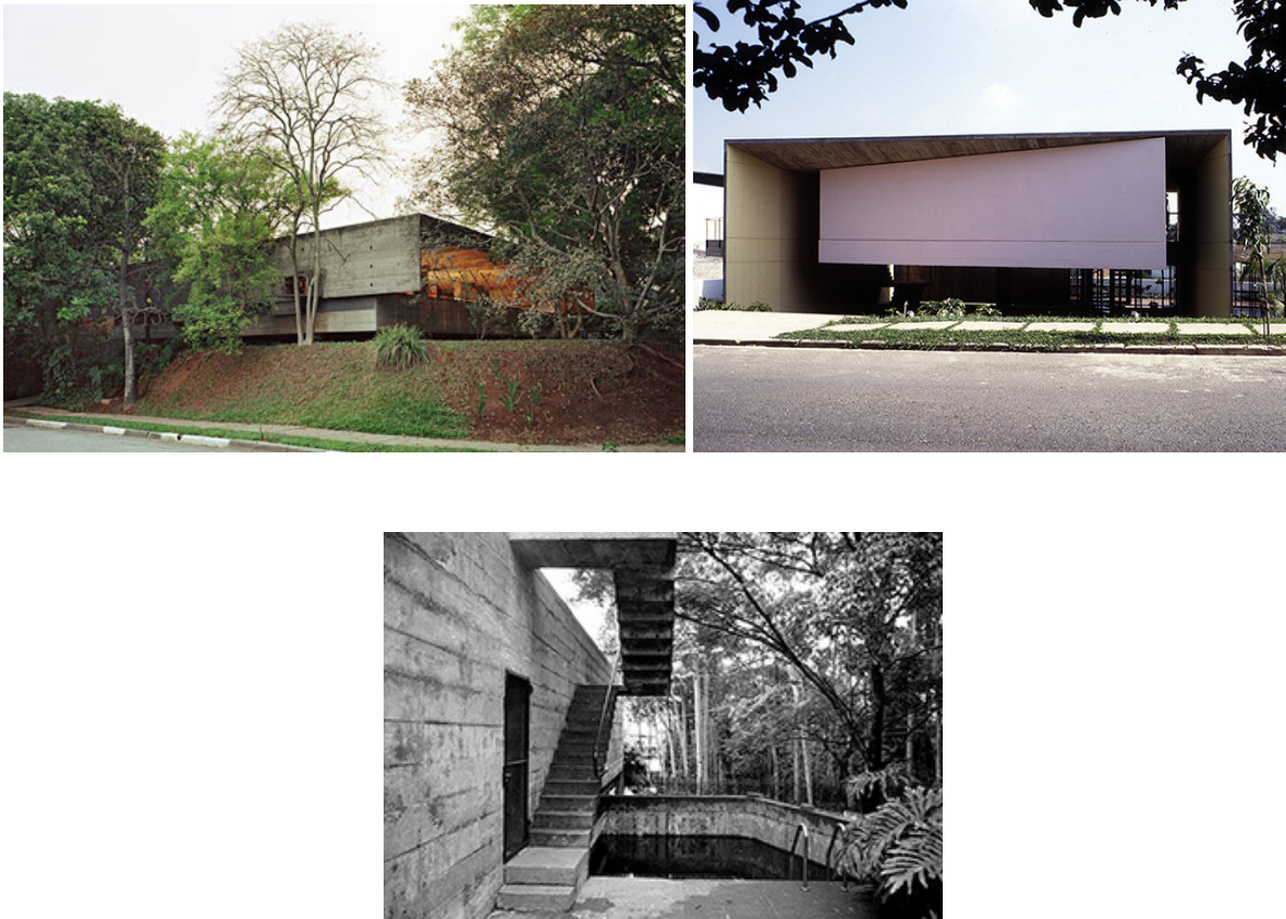
Figuras 64, 65 e 66 - Acima e à esquerda, Residência Mendes da Rocha; à direita, Residência Antônio Junqueira; ao centro, Residência Fernando Millan. Fontes: http://www.vitruvius.com.br ; KAMITA, João Masao. A casa moderna brasileira . In: Adrian Forty; Elisabetta Andreoli (Org.). Arquitetura Moderna Brasileira . Londres: PHAIDON, 2004, v., p. 140-169
