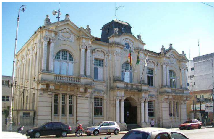
Figura 57: Fachada Principal do Palácio da Intendência. Fonte: Autora, 2010.
