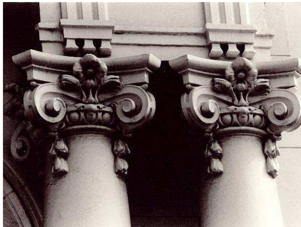
Figura 30: Capitéis das colunas do Palácio da Intendência.
