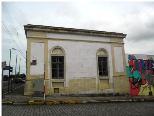
Figura 26: Fachada lateral. Fonte: A autora, 2012.
