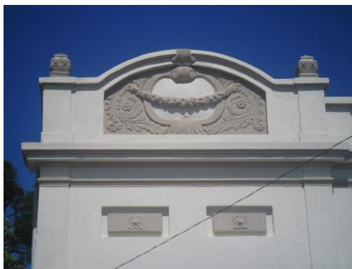
Figura 157: Detalhe frontão em arco. Fonte: A autora, 2012.
