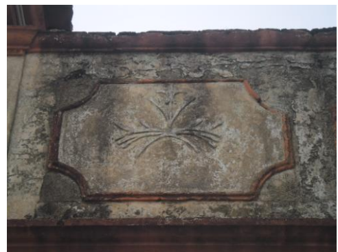
Figura 20: Detalhe fachada. Fonte: A autora, 2012.
