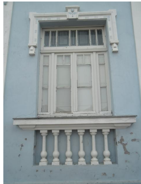
Figura 70: Detalhe da esquadria com falsos balaustres e balcão. Fonte: A autora, 2012.
