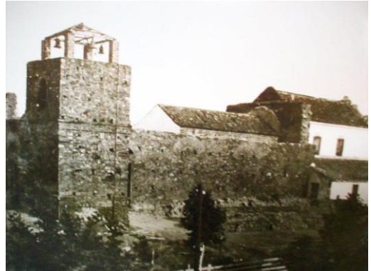
Figura 30: Fachada lateral, em construção. Fonte: acervo de Gelson Nunes de Oliveira, s/d.
