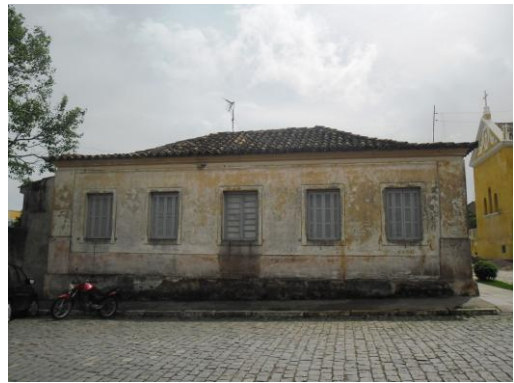
Figura 44: Fachada lateral. Fonte: A autora, 2012.
