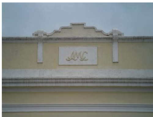
Figura 146: Detalhe tratamento decorativo na platibanda. Fonte: A autora, 2012.
