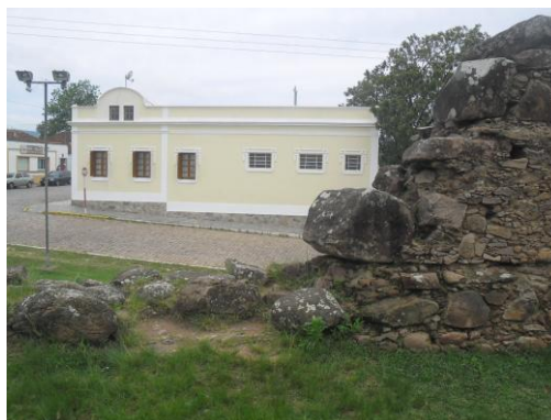
Figura 144: Fachada lateral. Fonte: A autora, 2012.
