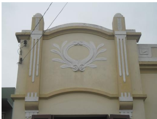
Figura 150: Detalhe platibanda. Fonte: A autora, 2012.
