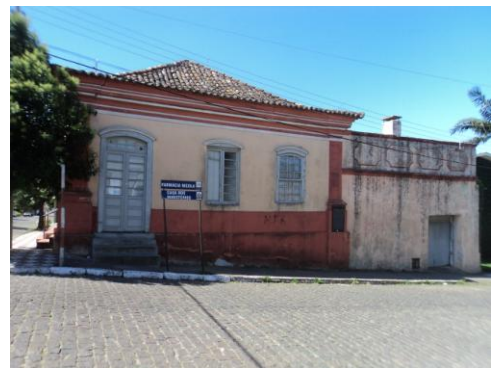
Figura 16: Fachada lateral. Fonte: A autora, 2012.
