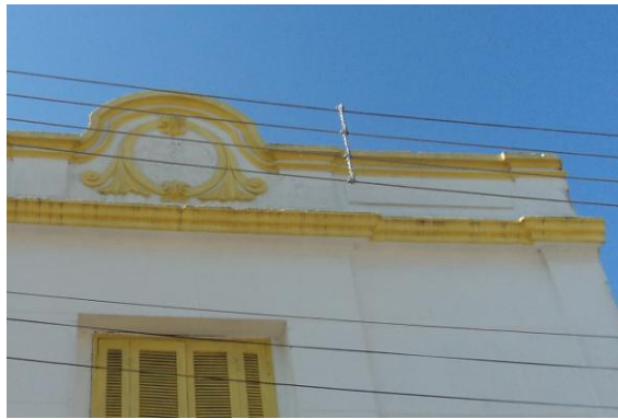
Figura 94: Detalhe frontão em arco. Fonte: A autora, 2012
