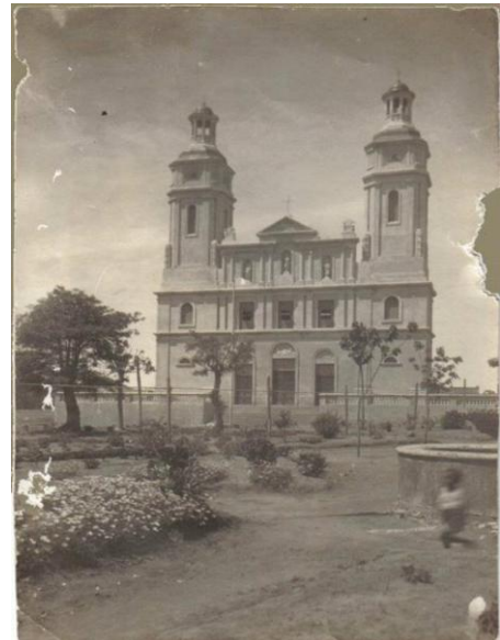
Figura 32: Obra finalizada. Fonte: acervo de Gelson Nunes de Oliveira, 1936.
