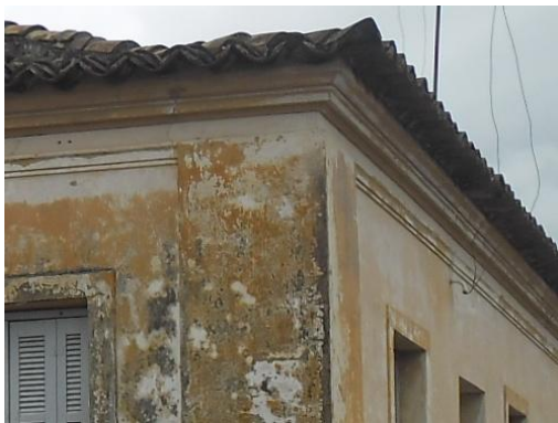
Figura 45: Detalhe cimalha e cunhal. Fonte: A autora, 2012.
