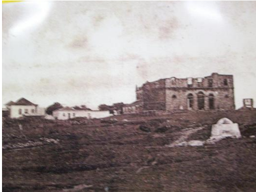
Figura 29: Início da construção. Fonte: acervo de Gelson Nunes de Oliveira, s/d.
