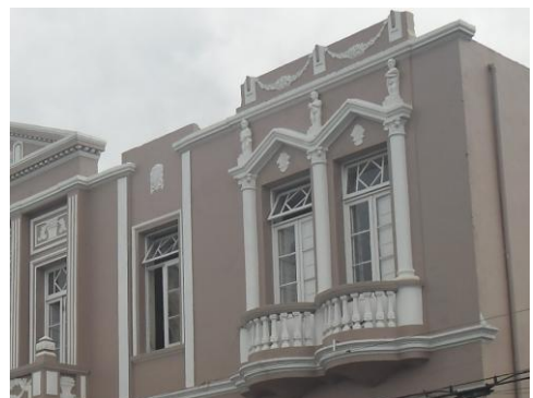
Figura 86: Detalhe balcão. Fonte: A autora, 2012.
