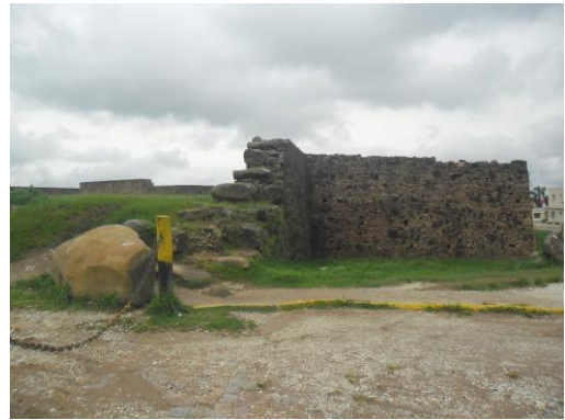
Figura 56: Vista lateral. Fonte: A autora, 2012.
