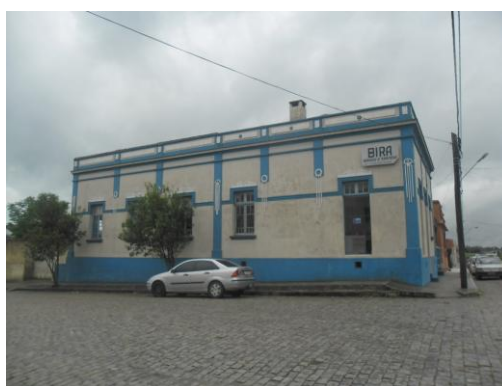
Figura 126: Fachada lateral. Fonte: A autora, 2012.
