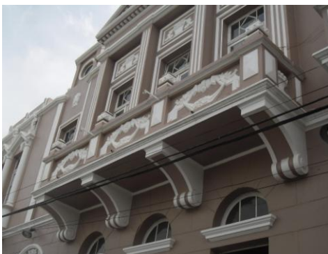
Figura 85: Detalhe sacada. Fonte: A autora, 2012.
