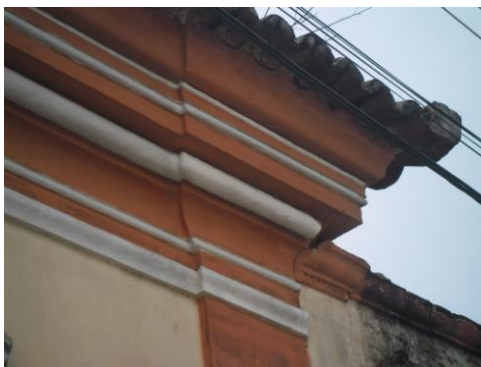
Figura 19: Detalhe cimalha. Fonte: A autora, 2012.
