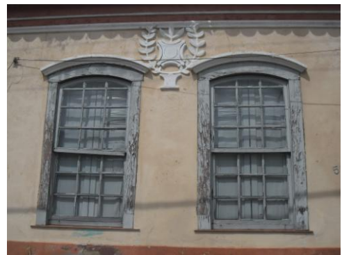
Figura 18: Escudo da família na fachada e janelas em arco abatido. Fonte: A autora, 2012.
