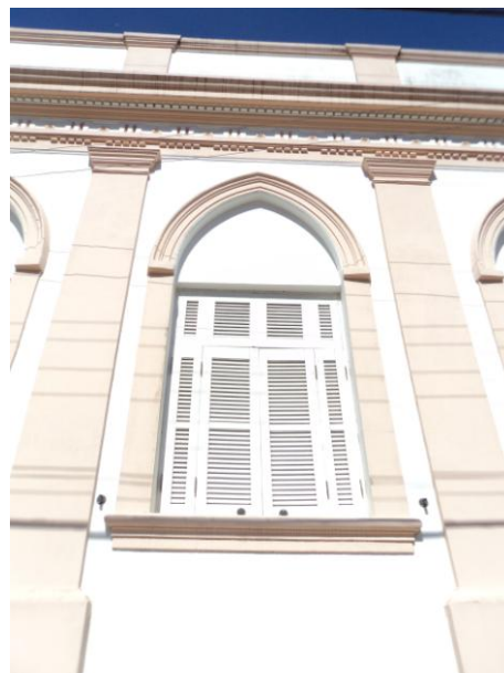
Figura 121: Detalhe esquadria com verga em arco ogival com cercadura. Fonte: A autora, 2012.
