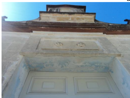
Figura 112: Detalhes na fachada. Fonte: A autora, 2012.
