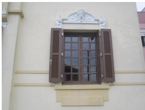
Figura 151: Detalhe esquadria com verga reta e cercadura decorativa. Fonte: A autora, 2012.
