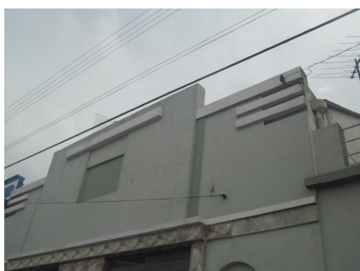
Figura 138: Detalhe tratamento decorativo na platibanda. Fonte: A autora, 2012.
