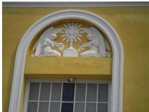
Figura 36: Detalhe da porta principal com arco pleno com cercadura e bandeira cega decorada. Fonte: A autora, 2012.
