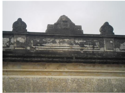
Figura 77: Detalhe da platibanda com pequeno frontão e pináculos. Fonte: A autora, 2012.
