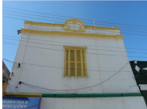
Figura 93: Detalhe segundo pavimento. Fonte: A autora, 2012
