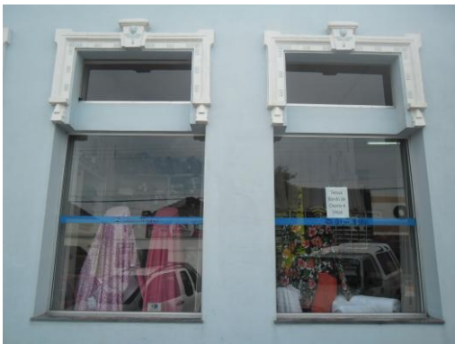
Figura 69: Detalhe esquadria com verga reta e cercaduras decorativas na parte superior. Fonte: A autora, 2012.
