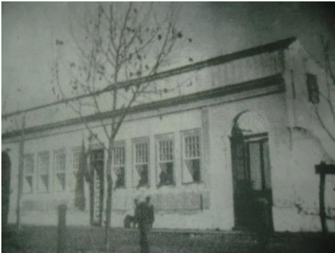
Figura 79: Edificação adquirida. Fonte: 100 Anos de "União", 1908.
