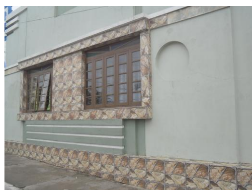
Figura 139: Detalhe esquadria com verga reta e elementos da fachada. Fonte: A autora, 2012.
