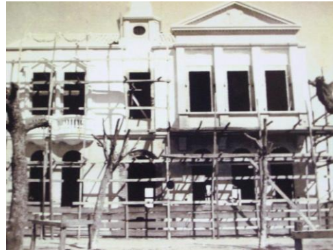
Figura 80: Construção do 2º piso da ala esquerda. Fonte: acervo de Gelson Nunes de Oliveira, s/d.
