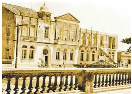
Figura 82: Construção da ala direita. Fonte: acervo de Gelson Nunes de Oliveira, s/d.
