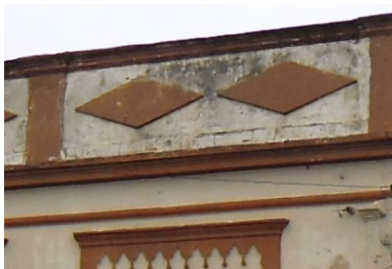
Figura 98: Detalhe da platibanda com elementos decorativos. Fonte: A autora, 2012.
