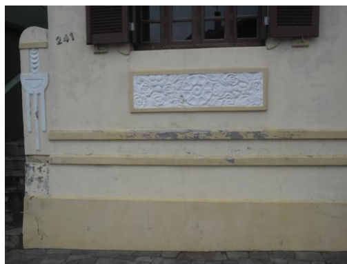
Figura 152: Detalhe elementos decorativos na fachada. Fonte: A autora, 2012.
