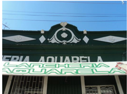
Figura 89: Detalhe frontão em arco. Fonte: A autora, 2012
