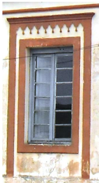
Figura 99: Detalhe esquadria com verga reta com cercadura. Fonte: A autora, 2012.
