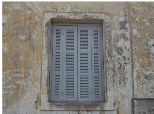
Figura 46: Detalhe esquadria com verga reta com cercadura. Fonte: A autora, 2012.
