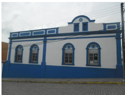
Figura 133: Fachada lateral. Fonte: A autora, 2012.
