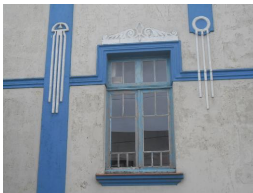
Figura 128: Detalhe esquadria com verga reta com cercadura. Fonte: A autora, 2012.
