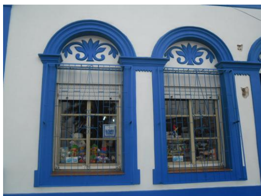
Figura 136: Detalhe esquadria com verga em arco pleno com cercadura. Fonte: A autora, 2012.
