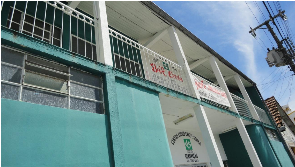
Figura 26: Fachada do Centro Cívico Cruz e Souza Foto: Eráclito Pereira – 02/2012
