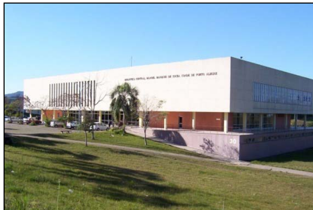
Figura 4 - Fachada da Biblioteca Central com o estacionamento à frente. Fonte: Arquivo da Biblioteca Central, 2012.
