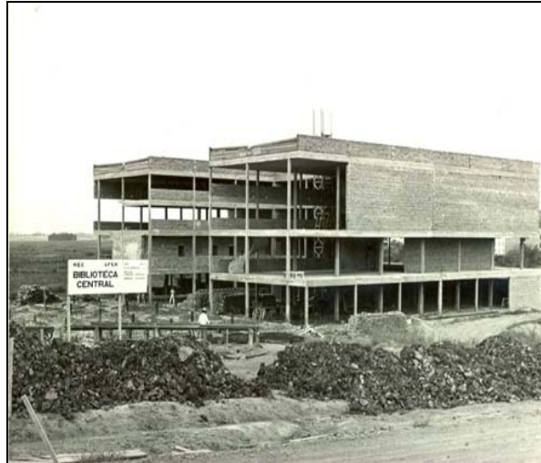
Figura 3 – Construção da Biblioteca Central. Fonte: Arquivo da Biblioteca Central.
