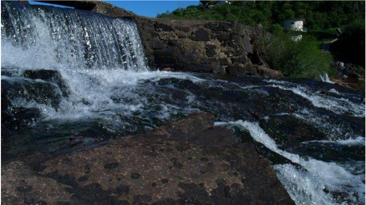
Figura 19 – Barragem do Paredão. Fonte: Daniele Moreira.
