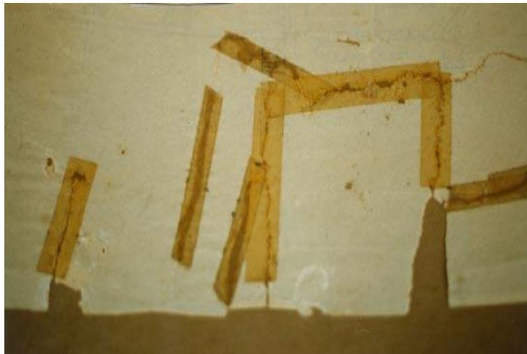
Figura 6 – Intervenção inadequada por fitas adesivas
