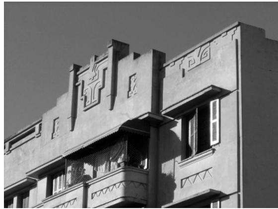
Figura 127 – Edifício “Raimundo João Cauduro”. Detalhe da platibanda escalonada e da aplicação do traçado geométrico de referência Marajoara e *zigue zague*.
