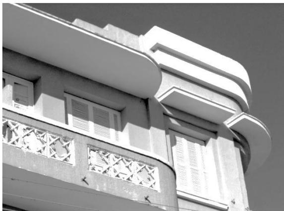
Figura 131 – Edifício Santa Maria. Detalhe dos frisos horizontais destacando a volumetria curva da esquina e elementos geométricos vazados dos balcões.
