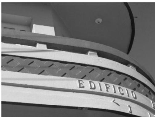
Figura 138 – Edifício Emérita. Detalhe da volumetria dos balanços curvos conformadores da esquina da edificação. Aplicação de detalhes geométricos *zigue zague* e letreiro em alto relevo com a nomenclatura do prédio.
