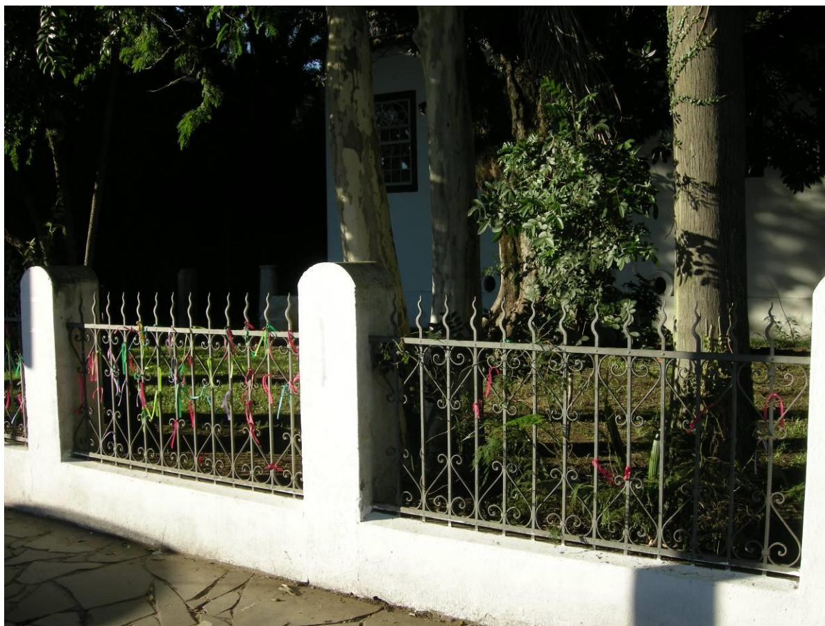
Figura 24: Foto do muro do Museu.
