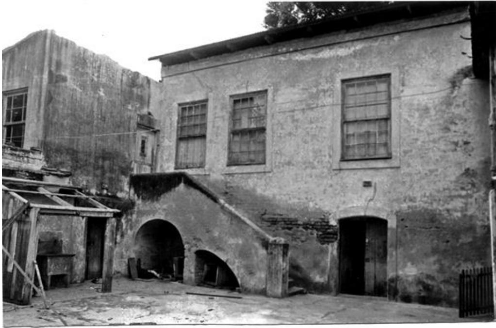
Figura 18: Interior do pátio com escada de acesso ao acréscimo nos fundos. Fonte: Acervo Fototeca Sioma Breitman.
