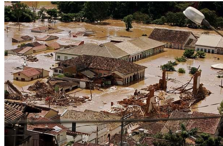
Figura 02: Vista da inundação na cidade de São Luís do Paraitinga.
