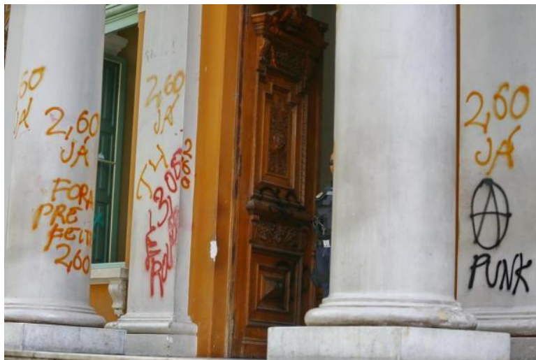
Figura 01: Fachada do Paço dos Açorianos. Fonte: Félix Zucco / Agência RBS, 2013.
