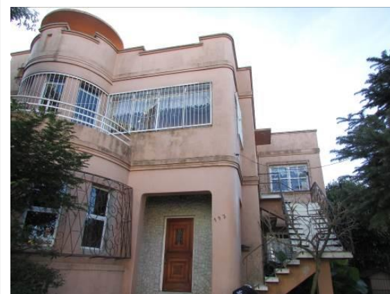
Vista da fachada dentro do terreno
