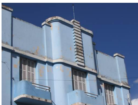
Detalhes da platibanda
