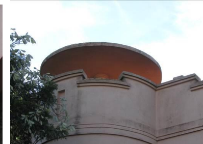
Marquise circular e platibanda
