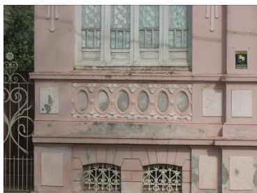
Detalhes abaixo das aberturas
