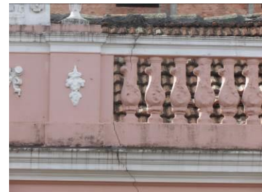
Balaustrada da platibanda
