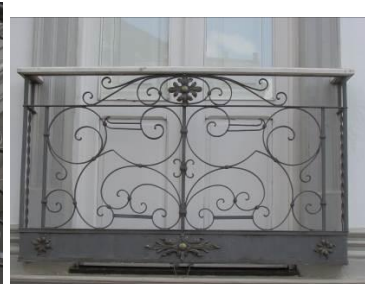
Balcão de ferro fundido
