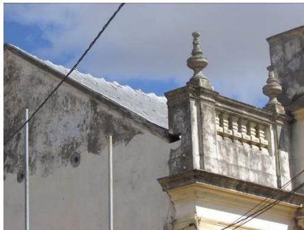
Platibanda e telhado
