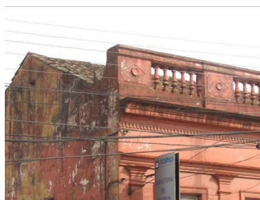
Platibanda e telhado
