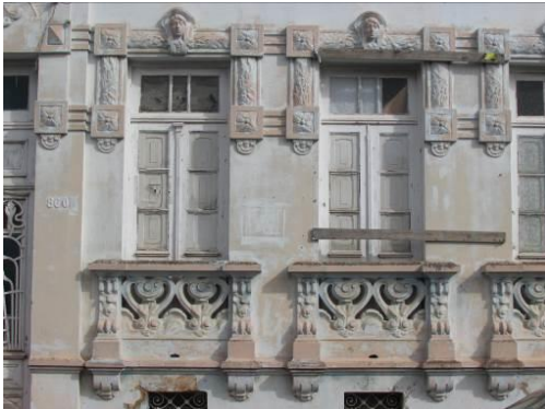
Disposição das portas-janelas
