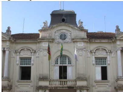
Balcão com porta-janela
