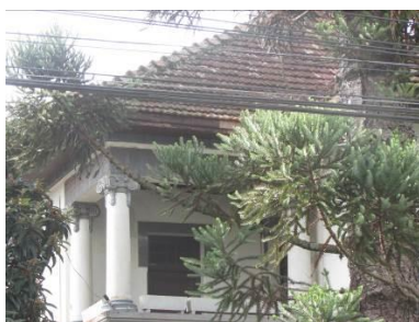
Vista do terraço coberto
