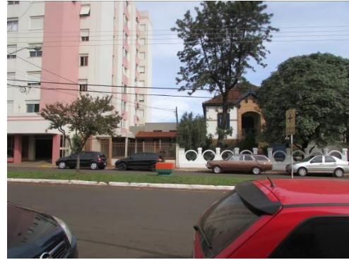
Entorno da edificação – lado esquerdo
