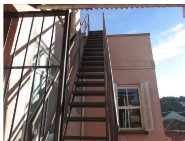
Escada atual de acesso ao terraço
