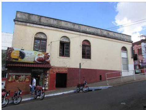
Fachada lateral esquerda
