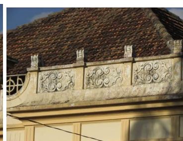
Platibanda e telhado
