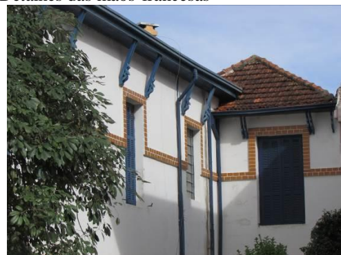
Aberturas na lateral direita
