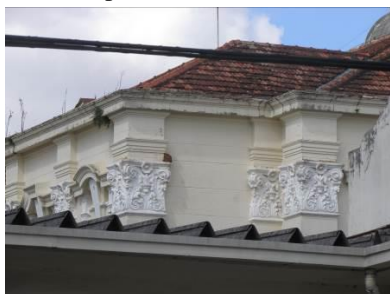
Parte do telhado
