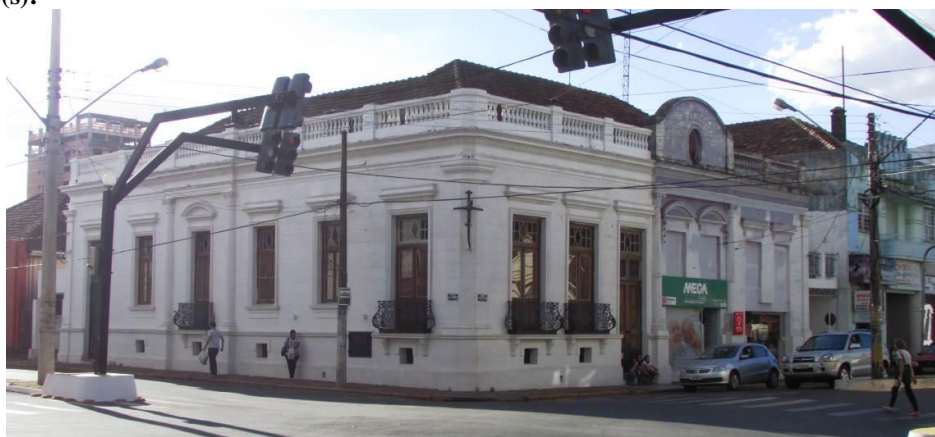
Fachada diagonal Casa Veríssimo Lopes
