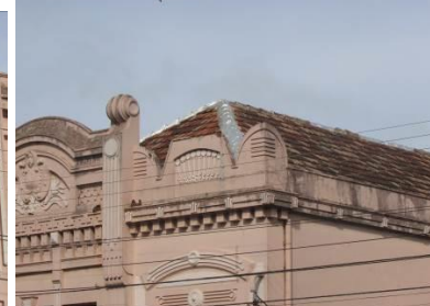
Platibanda e telhado
