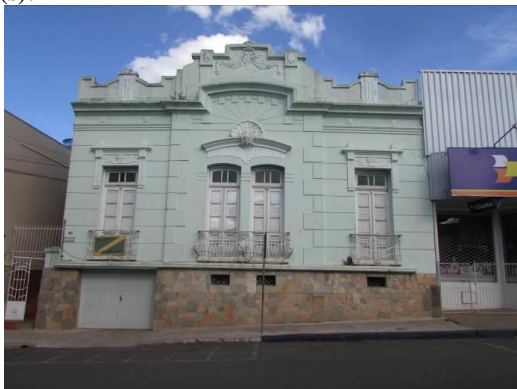
Fachada frontal da Casa Lupinacci
