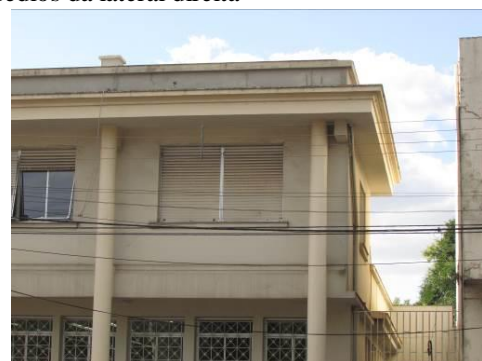
Marquise beiral e platibanda
