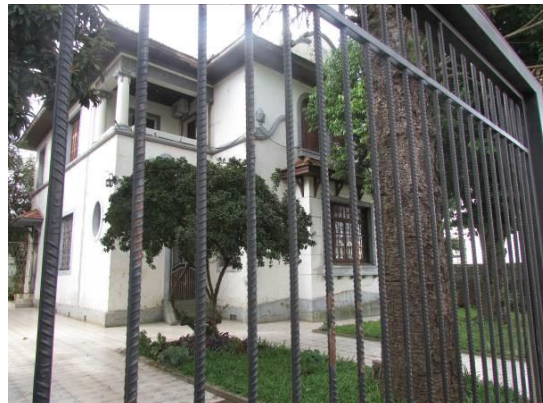
Vista interna fachada
