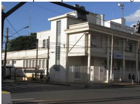
Fachada diagonal esquerda
