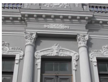
Colunas de ordem compósita
