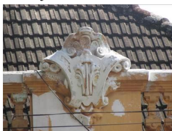
Ornamentação pontual da platibanda
