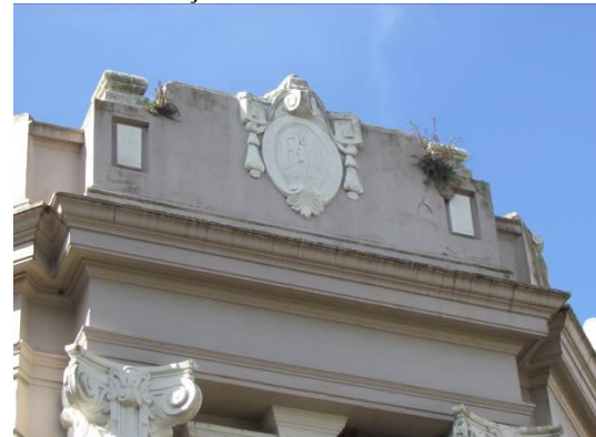
Coroamento do alinhamento vertical da entrada
