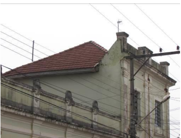
Platibanda e telhado
