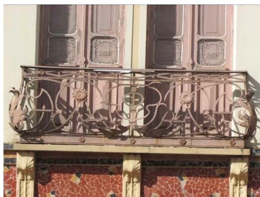
Balcão de ferro das portas-janelas
