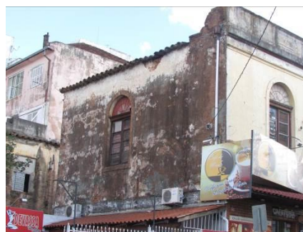
Fundo da edificação
