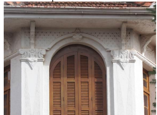
Coroamento de janela com verga circular
