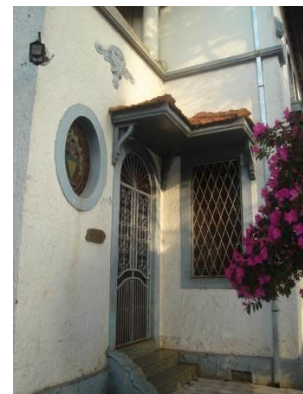
Acesso e aberturas frontais
