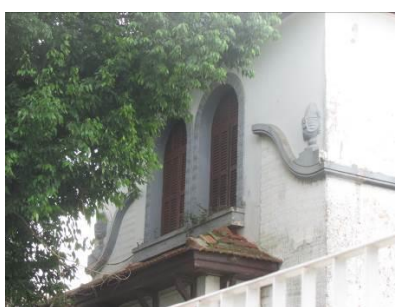
Elementos decorativos fachada
