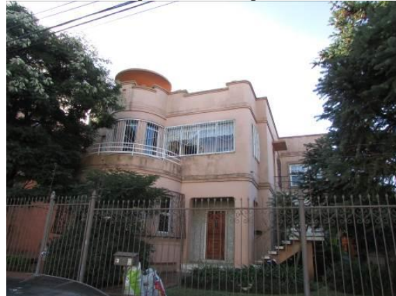
Vista da fachada a partir do passeio
