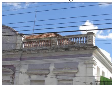
Balaustrada na platibanda
