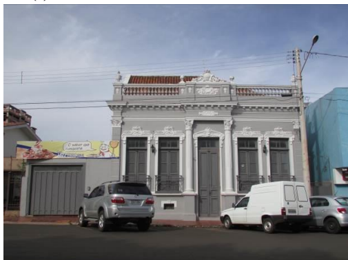
Fachada Casa Veríssimo de Azambuja
