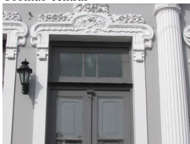
Detalhe de abertura
