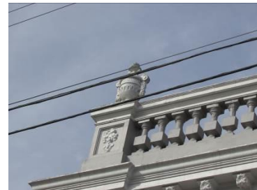
Balaustrada e vaso decorativo
