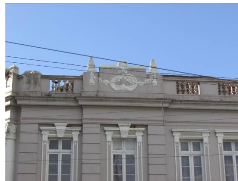
Platibanda com balaustradas e frontão
