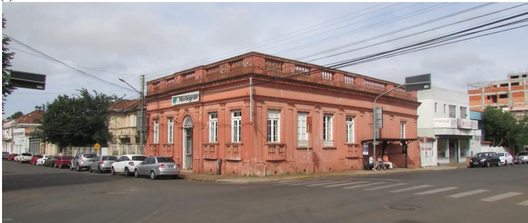
Vista da esquina da Casa Schmitt
