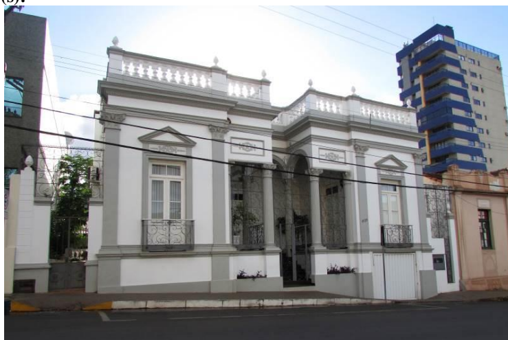
Fachada da Casa Rocha Montenegro
