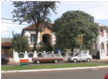
Fachada Solar Brandão
