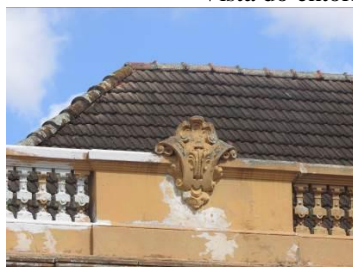
Ornamentação da platibanda
