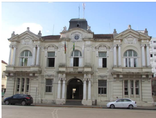
Fachada Prédio da Prefeitura Municipal
