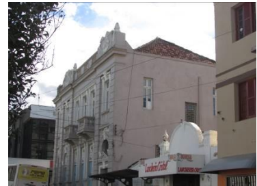
Fachada fundos e telhado
