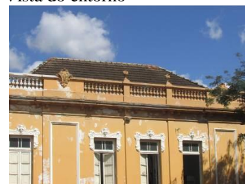
Balaustrada da platibanda
