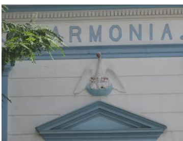
Elementos da fachada
