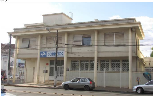
Prédio dos Correios de Cruz Alta
