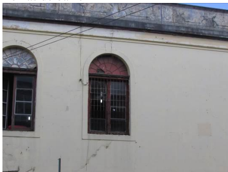
Aberturas com vergas em arco
