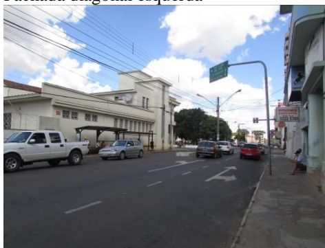
Entorno e fundos da edificação
