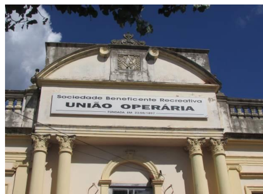
Detalhe do Frontão
