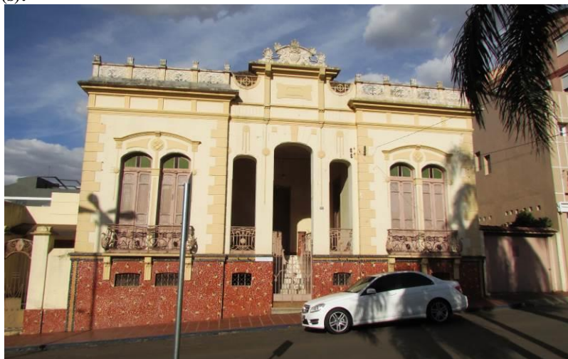
Fachada frontal da Casa Dumoncel
