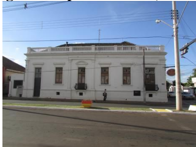
Fachada lateral esquerda
