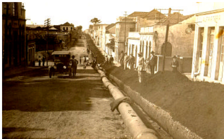
FIGURA 1 – Implantação da rede de esgoto.
