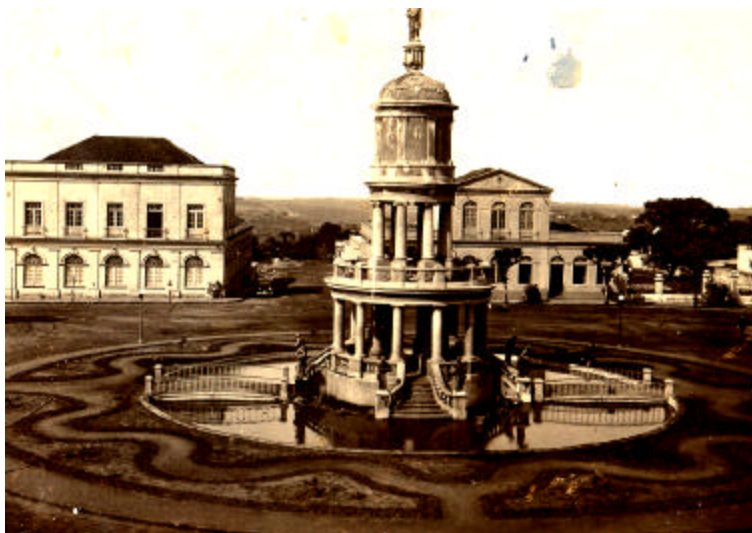
FIGURA 6 – Reservatório Château d'Eau em 1924.
