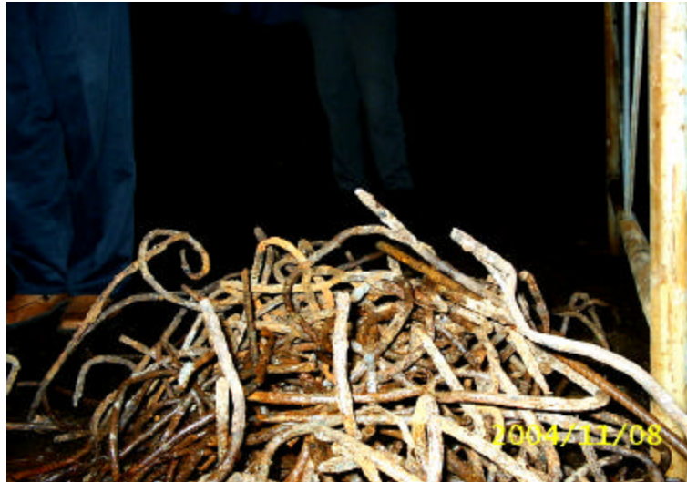
FIGURA 27 – Armadura oxidada removida.
