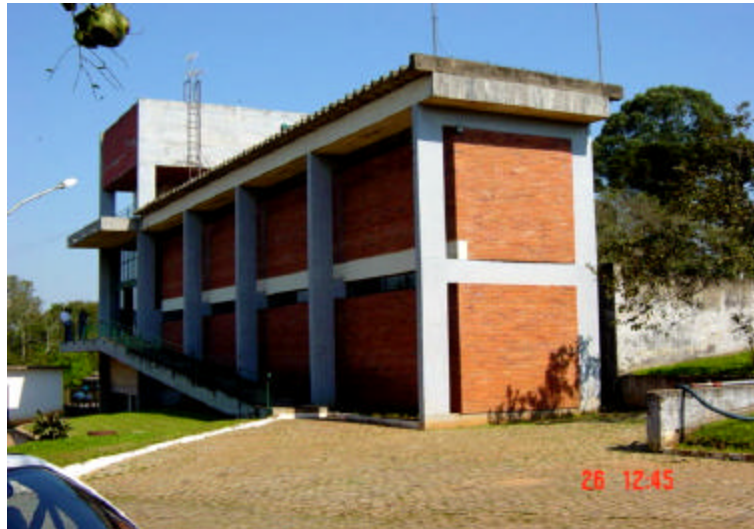
FIGURA 10 – Vista da atual Estação de Tratamento de Água.
