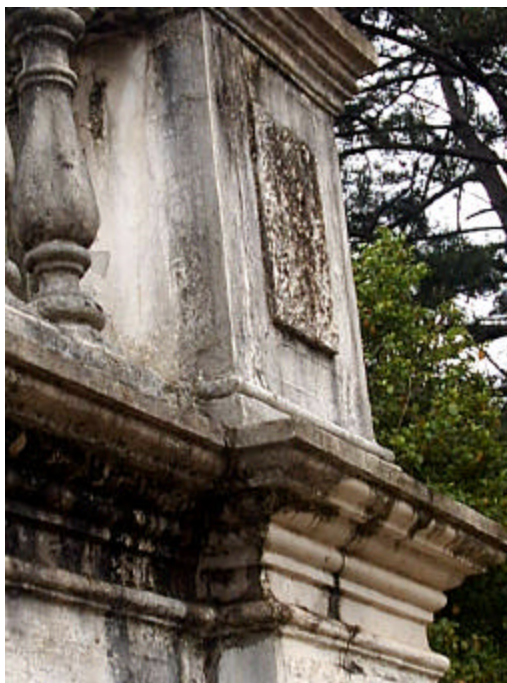
FIGURA 39 – Detalhe das molduras de fachada.
