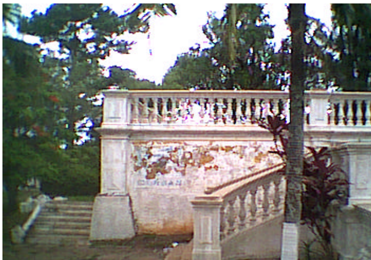
FIGURA 35 – Pintura com várias camadas de cal.
