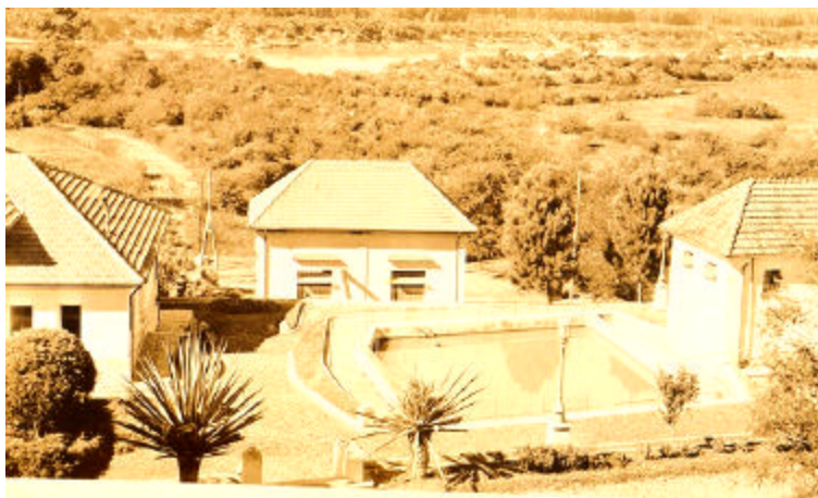
FIGURA 5 – Vista geral da nova hidrúlica.
