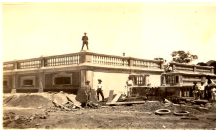
FIGURA 11 – Vista da obra em 1924.
