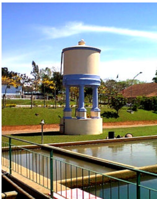
FIGURA 8 – Reservatório reciclado para depósito de sulfato.
