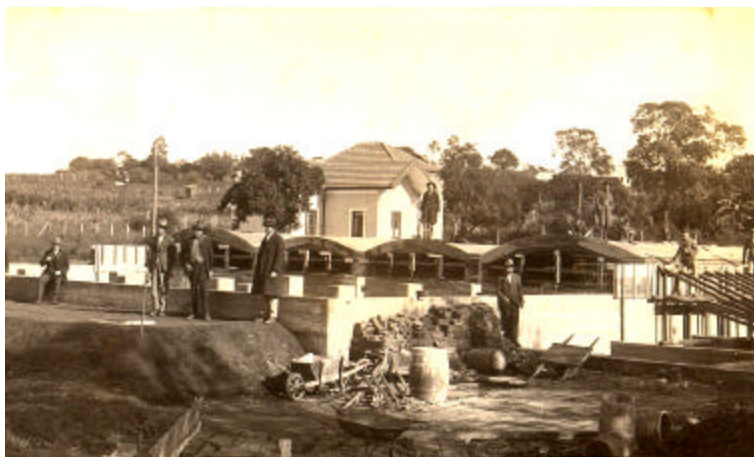
FIGURA 12 – Construção do Reservatório R2.
