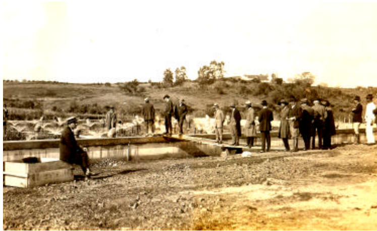
FIGURA 4 – Estação de tratamento de esgoto.
