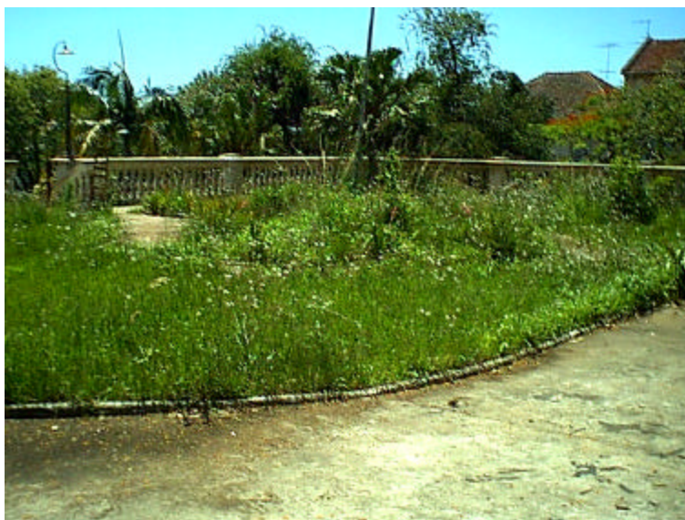
FIGURA 31 – Passeios recobertos com argamassa.
