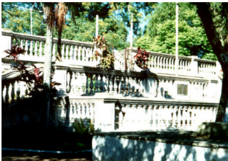
FIGURA 30 – Características arquitetônicas ainda originais.
