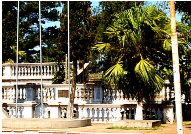
FIGURA 16 – Vista atual das escadarias.
