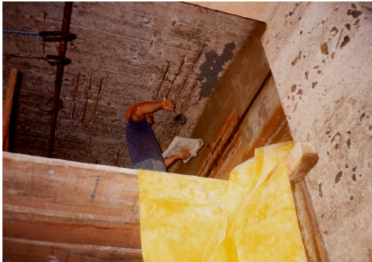
FIGURA 29 – Reconstituição da superfície, argamassa tixotrópica.
