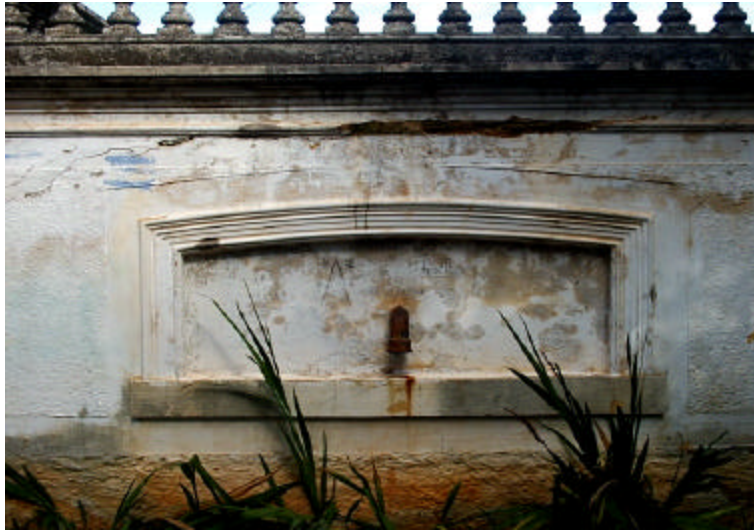
FIGURA 34 – Detalhe da molduras das janelas.
