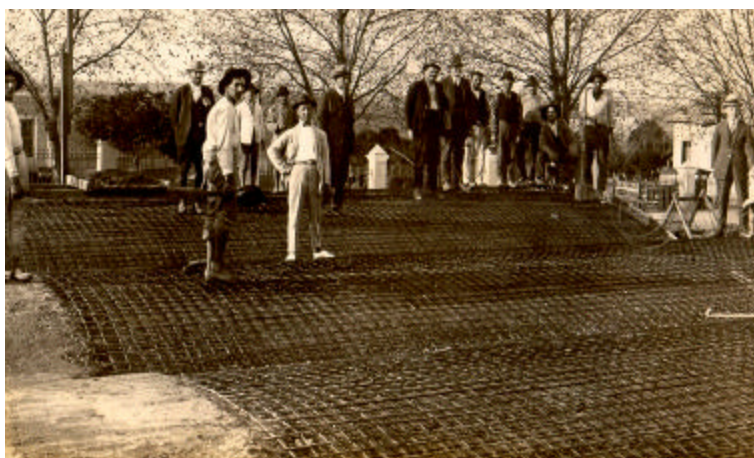
FIGURA 13 – Detalhe da armadura da cúpula cilíndrica.
