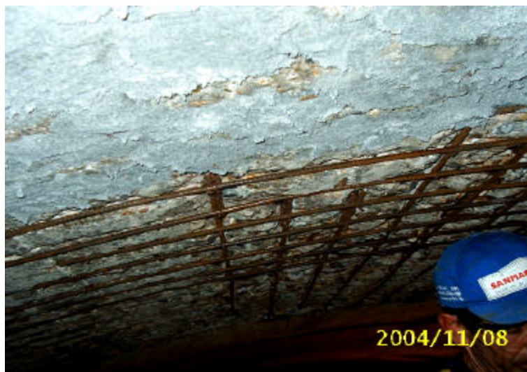
FIGURA 28 – Fixação da nova armadura.
