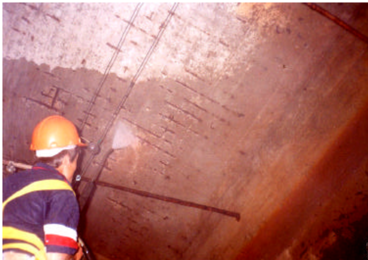
FIGURA 25 – Processo de hidro-jateamento.
