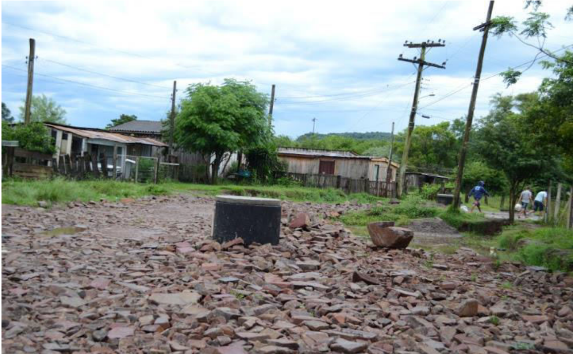
Figura 7-Tubos do encanamento prejudicando a circulação de veículos Fonte: Revista O Viés.
