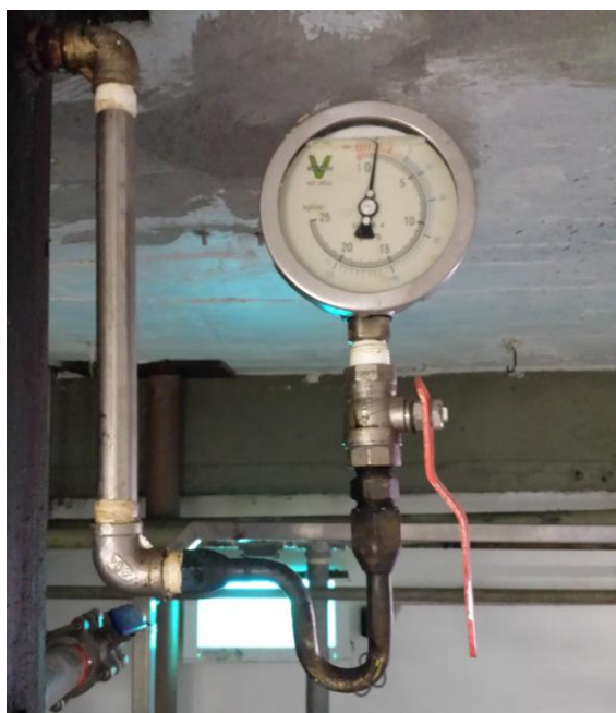
Manômetro com a pressão de trabalho no tanque de reevaporação. Fonte: Produção do próprio autor.
