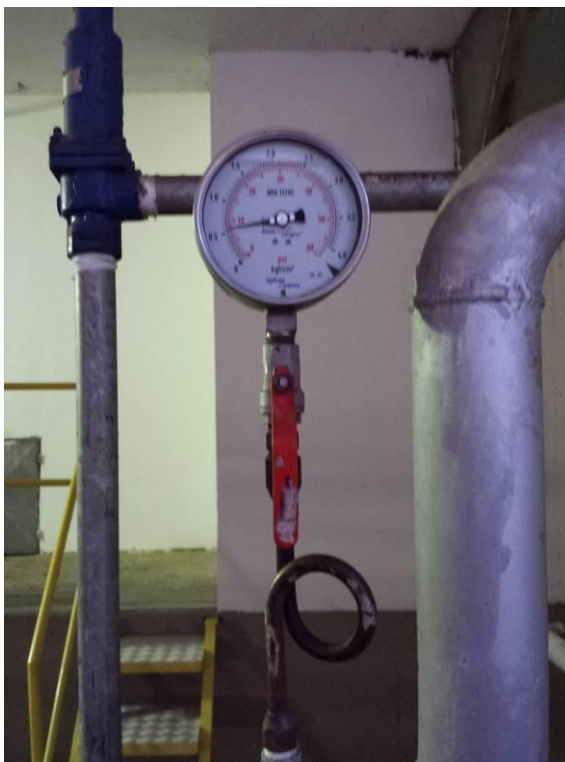
Manômetro com a pressão de trabalho no trocador de calor. Fonte: Produção do próprio autor.
