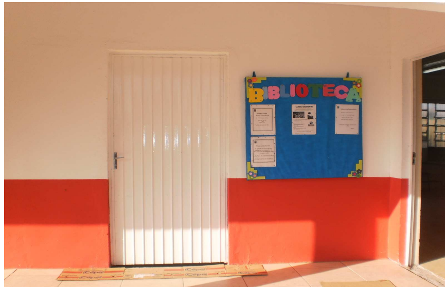
Fotografia 3- Porta de acesso principal. Fonte: Autora, 2014.
