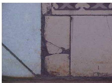
Figuras 31 a 36 – Colocação de ladrilhos em posições trocadas, devido à falta de peças para reposição. (DA GUIA, MEDEIROS, DE SOUZA, 2002).
