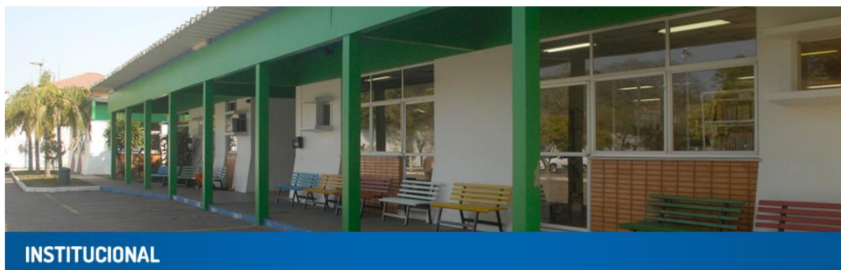
Figura 5: Prédio da Escola Marco
