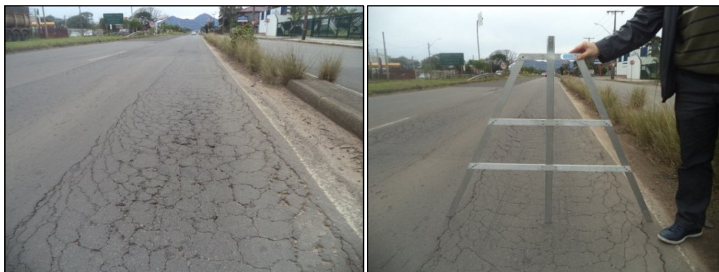
Figura 2.5 – Medição do ATR com treliça - RS 509 (área urbana Santa Maria)
