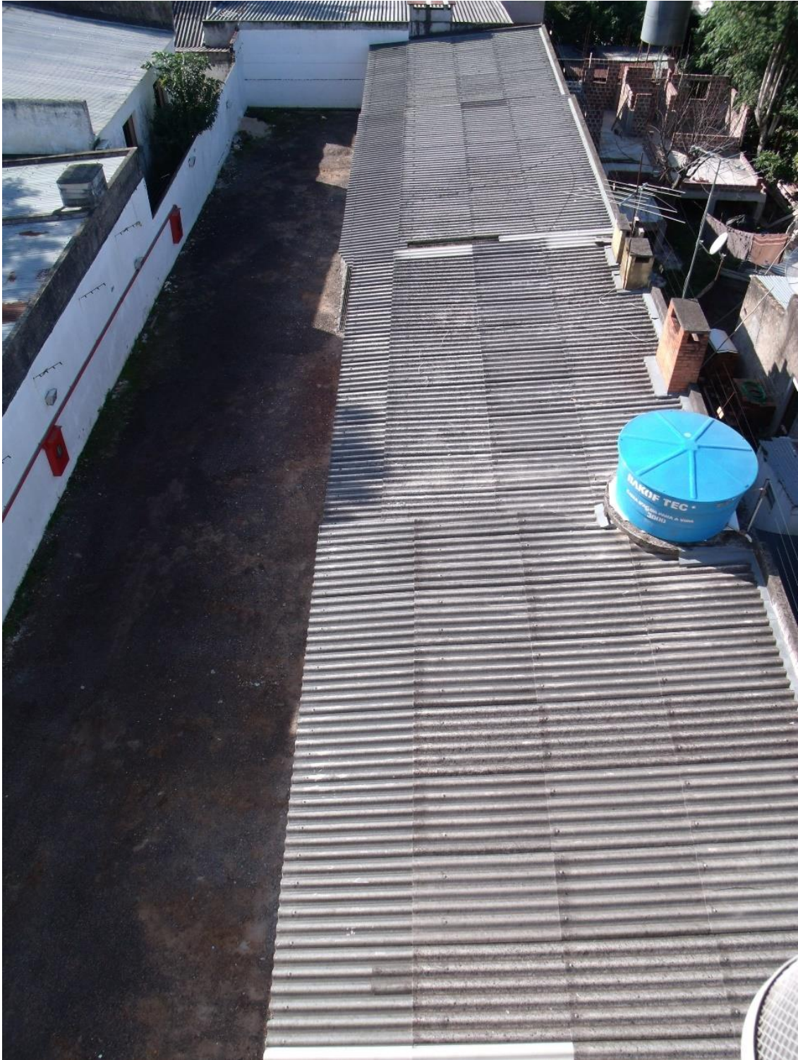
Figura 14 - Vista superior da área coberta das garagens
