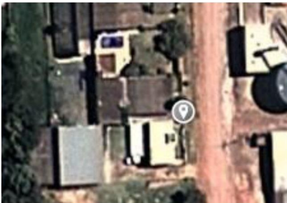
Figura 3.2 – Localização da Edificação
