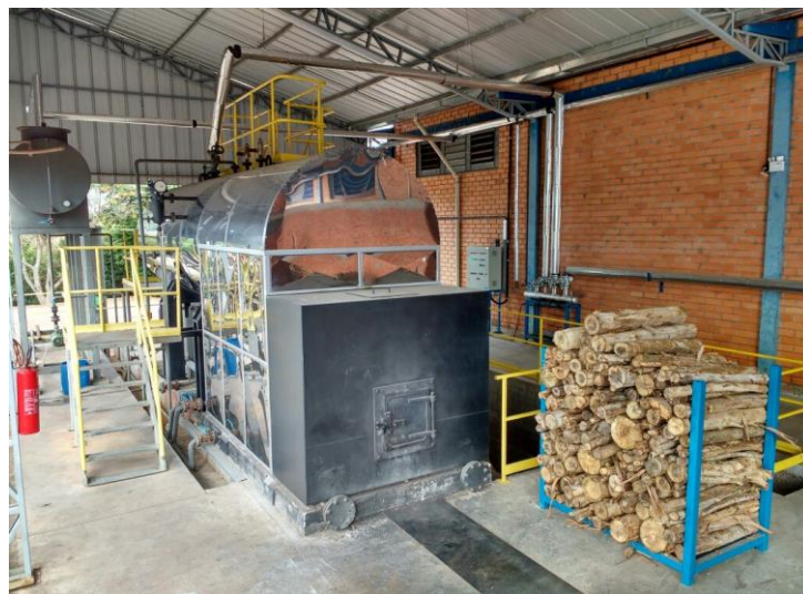
Figura 3 - Casa da Caldeira da Empresa Apolichs do Sul
