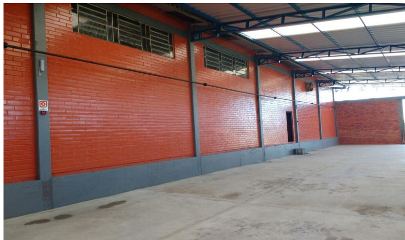
Figura 4 - Trecho de tubulação de vapor sem isolamento térmico
