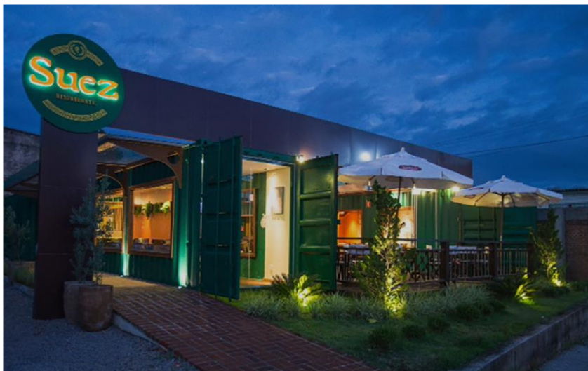
Figura 3 - Imagem da edificação
