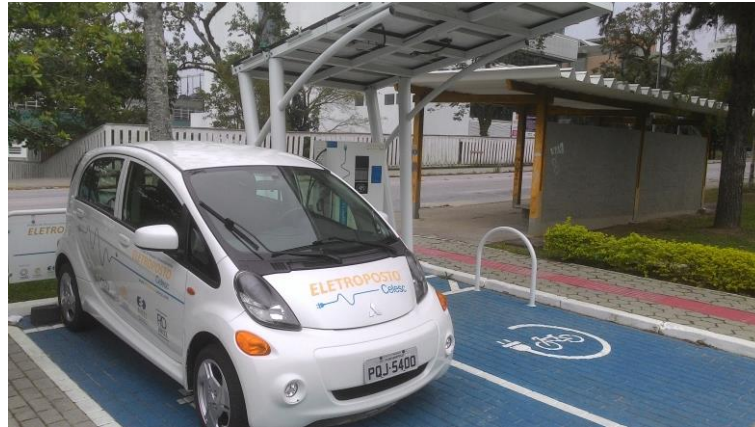
Figura 4.2 – Estação de recarga (carregamento lento) instalada na sede da Fundação CERTI em Florianópolis.
