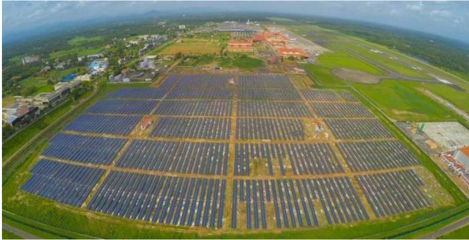
Figura 23 - Painéis instalados no Aeroporto Internacional de Cochin , na Índia
