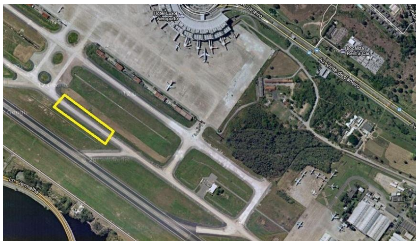
Figura 16 – Local de instalação do balizamento solar no Aeroporto Internacional do Rio de Janeiro
