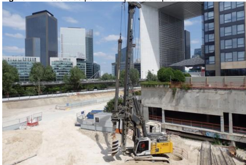
Figura 2 – Modelo de perfuratriz para estaqueamento.
