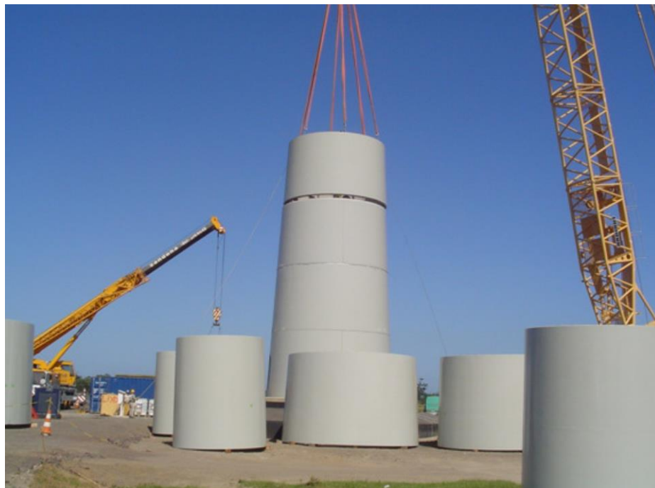
Figura 22 – Montagem de torre eólica
