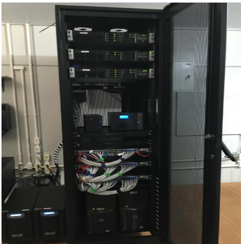
Figura 3: Parte da estrutura de TI montada na Empresa Ramos e Copini Autopeças (Fonte: dos autores, 2016)
