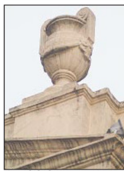
A unidade deteriora a pintura
