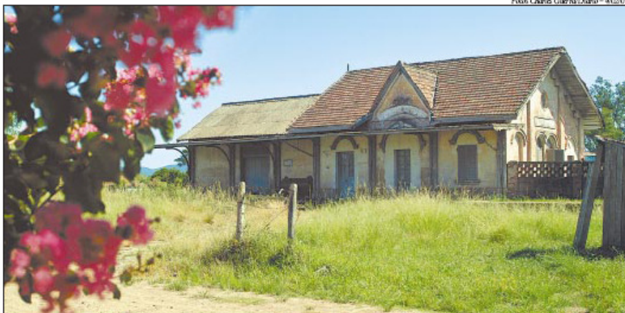
O prédio da antiga estação está em situação de abandono, mas ainda conserva a beleza dos tempos áureos da estrada de ferro
