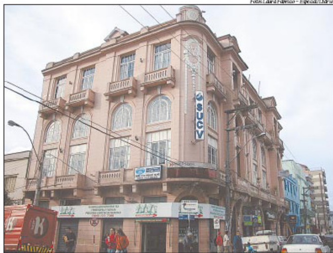
Polição visual distorça as características arquitetônicas do edifício inaugurado no ano de 1926
