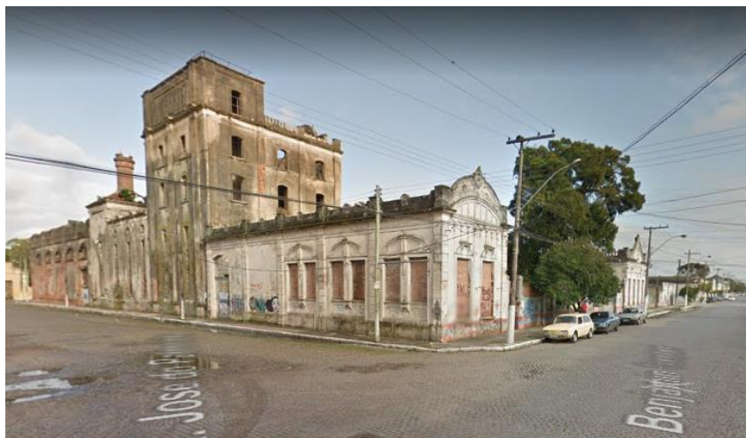
Figura 3 – Ruínas do prédio da Cervejaria Rio-Grandense em junho de 2011 Fonte: Captura de imagem no Google Maps.
