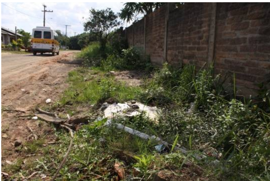
Figura 3 - Imagem demonstra que além da falta de pavimentação, também há falta de acostamento e calçada, dificultando o escoamento de água, e ainda o espaço é utilizado para depósito de lixos.
