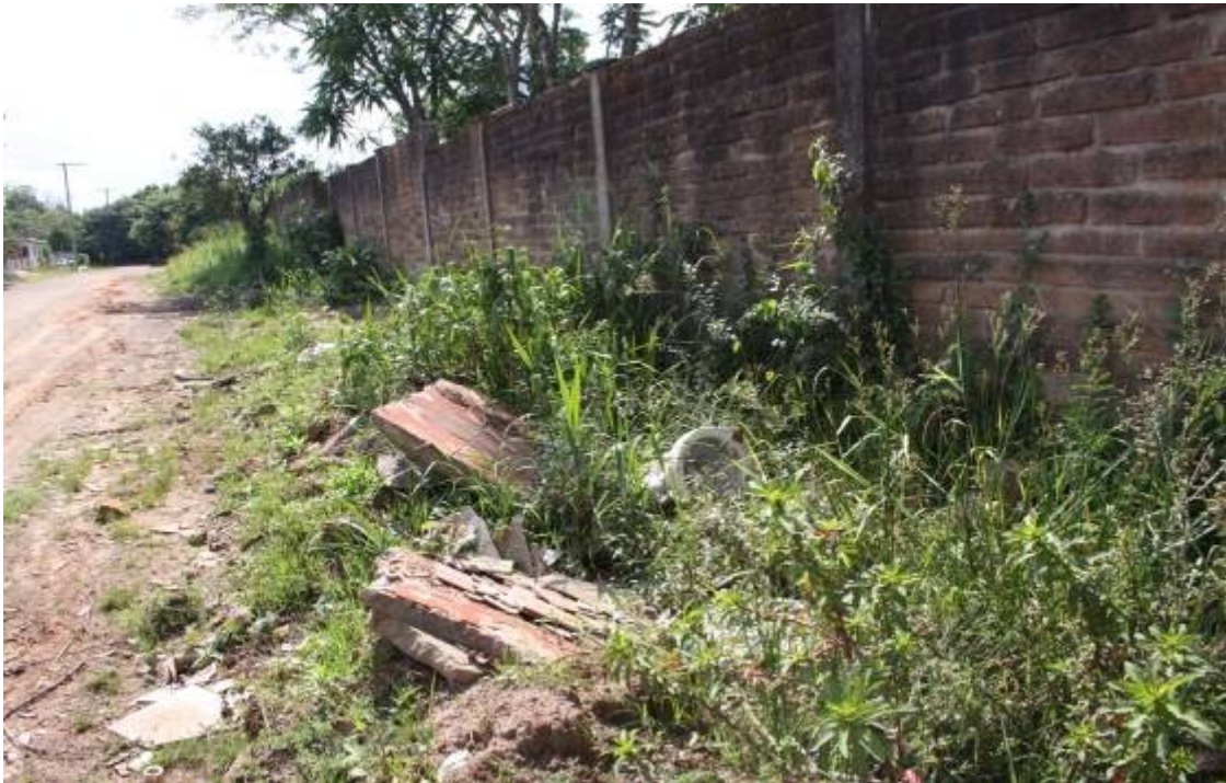
Figura – 1 – Mostra o descarte de matérias e entulhos de restos de construção ao lado do muro da escola.
