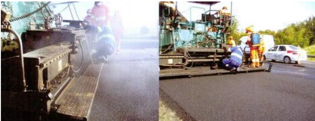
Figura 8 - Diferença de emissões de fumos de asfalto em pista entre mistura morna (à direita) e mistura a quente (à esquerda)
