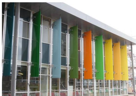
Figura 45: Brise vertical. Escola na Inglaterra. Fonte: <http://www.integralltd.co.uk>.
