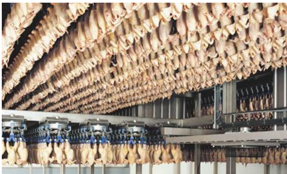
Figura 2.1.3 Sistema de resfriamento de carcaças tipo Air chiller
