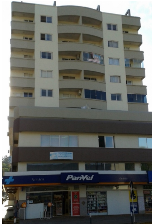
Figura 7: Imagem da fachada principal do edifício.
