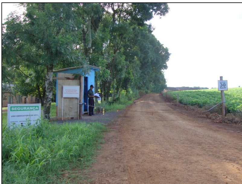
Figura 02 – Entrada ao canteiro de obras informando velocidade máxima permitida.
