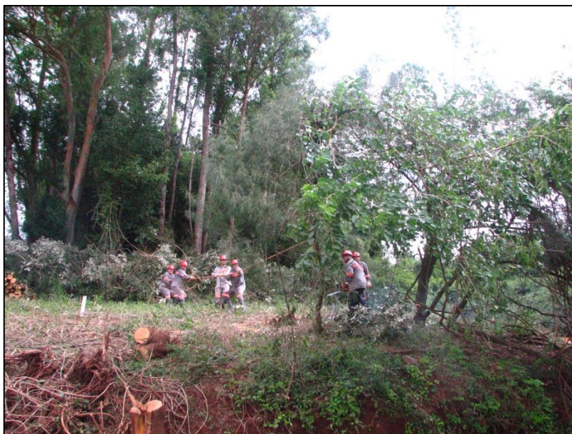
Figura 05 – Equipe realizando corte da vegetação da área do canal de fuga.
